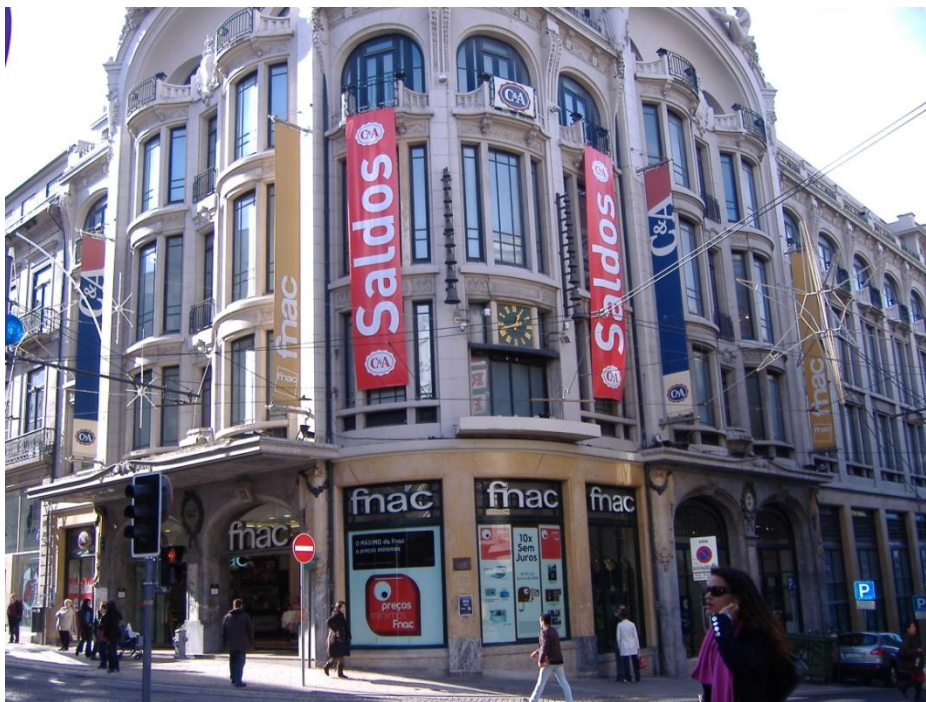
Figura 14 – Edifício Palladium. Fonte: autor
