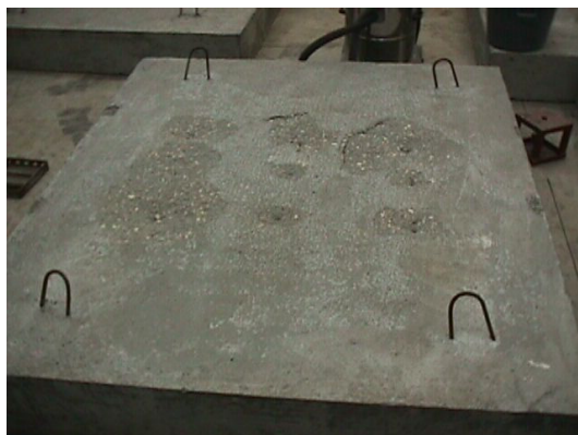
Figura 4.7 – Aspecto de uma laje de ensaio.
