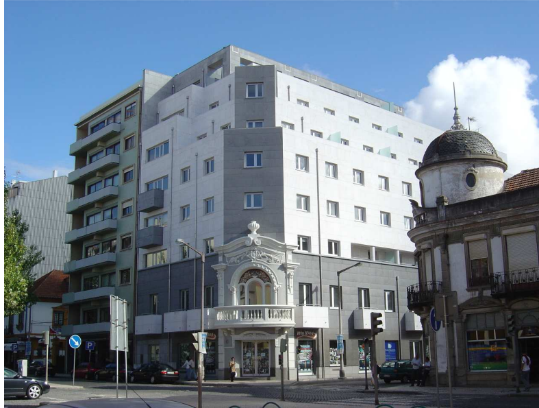
Figura 31: Edifício Severim Duarte, descaracterizado pela introdução de uma volumetria de cinco mais dois pisos recuados (foto de 2005)
