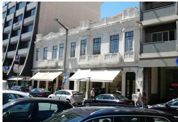
Figura 75: Edifício Aníbal Ramos e Francisco Piçarra
