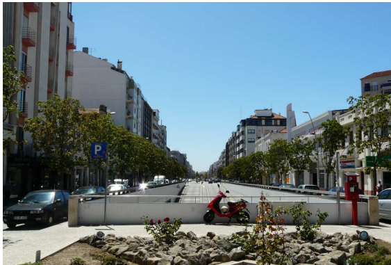
Figura 56: Vista da Alta da Avenida, com os dois alinhamentos separados devido ao túnel
