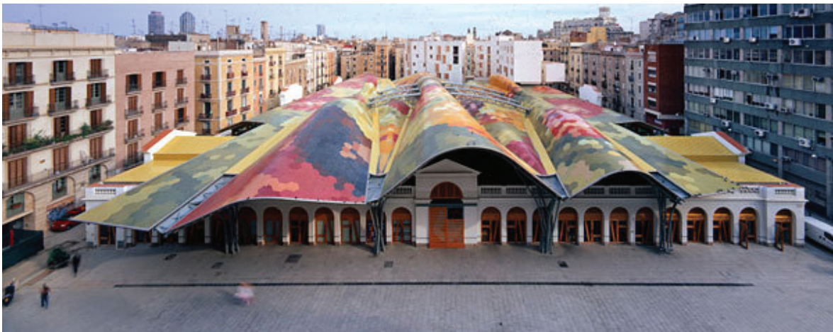
33 - Interior do Mercado de Santa Caterina; 34 - Pormenor da cobertura; 35 - Cuines Santa Caterina , o restaurantes integrado no mercado; 36 - Entrada principal; 37 - Vista aérea do Mercado.
