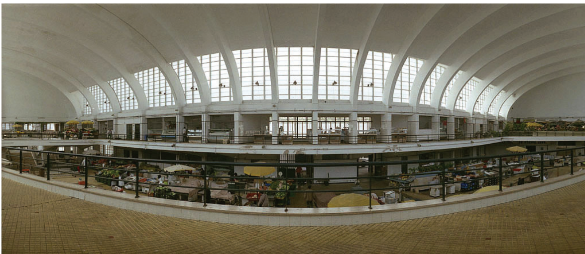
74 - Interior do Mercado do Bom Sucesso, Março 2010.
