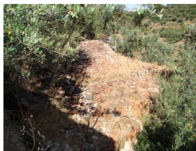
Fig. 50 – Imagem da estrutura exposta da cúpula da Ermida de Nª Sª do Paraíso.
