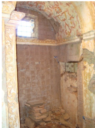
Fig.18 - Capela lateral esquerda.
