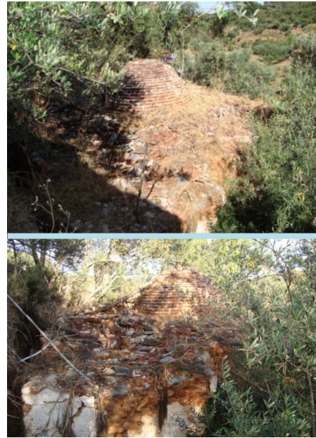
Fig.24 – Estrutura exposta da cúpula e cobertura da sacristia
