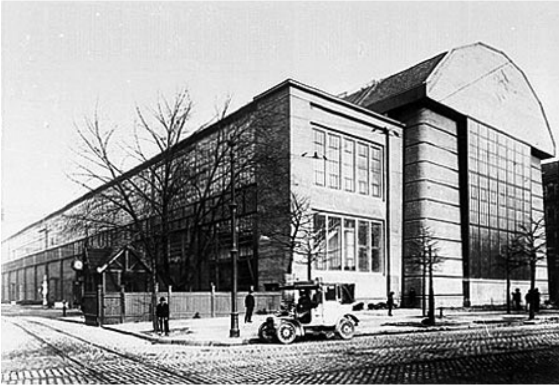
16. Fábrica de Turbinas para a AEG, Berlim.
