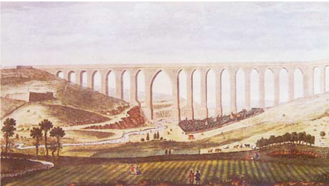
8. Aqueduto das Águas Livres, Lisboa.
