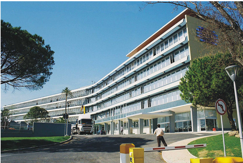
Fig 148. Nova sede da RTP (antiga DIALAP) - Vista exterior.
