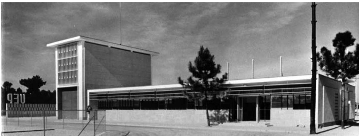
Fig 45. Subestação da UEP de Coima.
