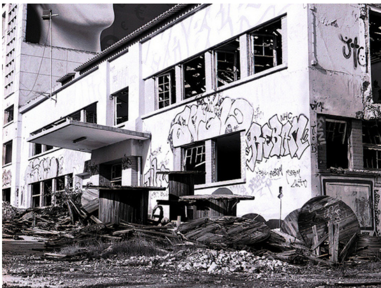
Fig 123. Actual estado da Fábrica de cabos eléctricos Diogo D'Ávila, Amadora.
