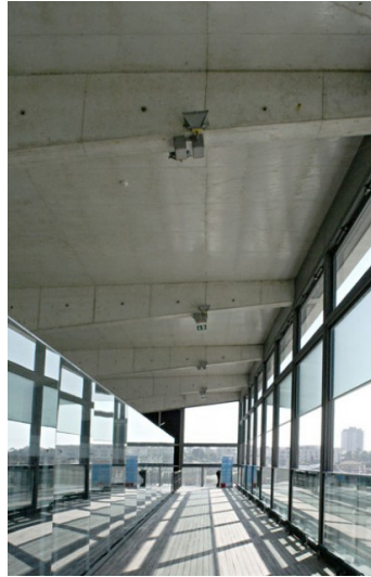
Fig 204. Edifício Transparente após a intervenção - vista interior.
