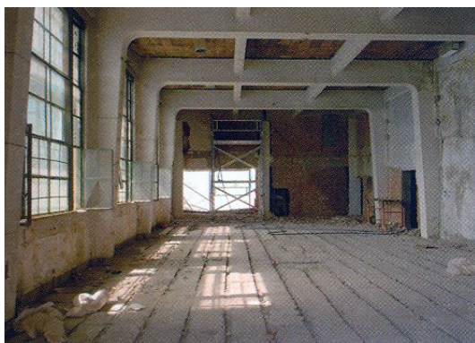
Fig 238. Vista interior durante o decorrer da obra.
