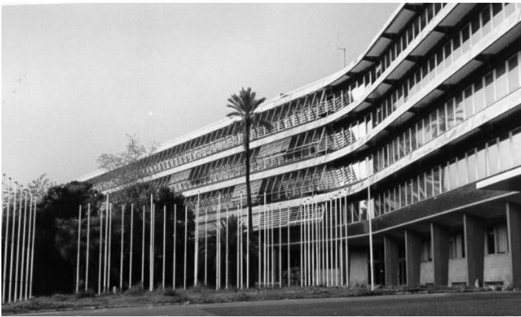
Fig 98. DIALAP – Edifício fabril e administrativo.
