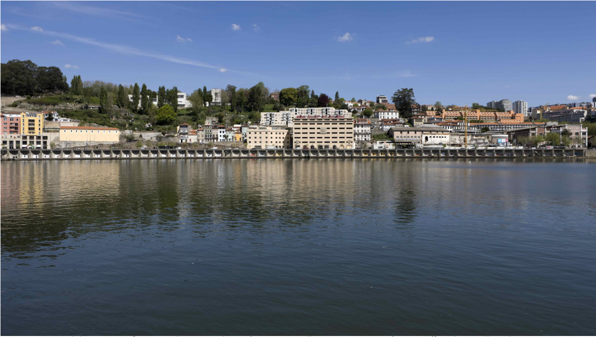
Fig 172. Marginal do Douro na freguesia de Massarelos após a intervenção no antigo Armazém Frigorífico do Bacalhau do Porto.
