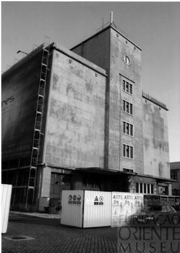
Fig 221. Vista do Armazém Frigorífico do Bacalhau de Lisboa antes da intervenção (Poente).
