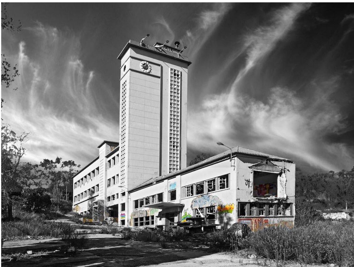
Fig 122. Actual estado da Fábrica de cabos eléctricos Diogo D'Ávila, Amadora.
