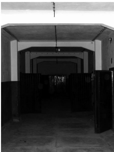
Fig 188. Corredor de distribuição antes da intervenção.
