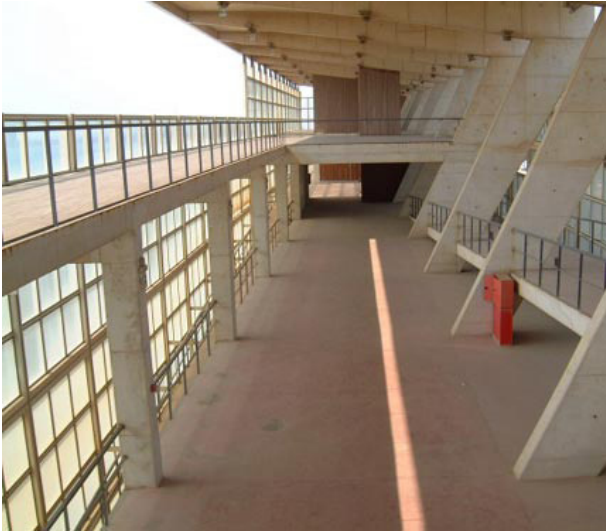
Fig 203. Edifício Transparente antes da intervenção - vista interior.
