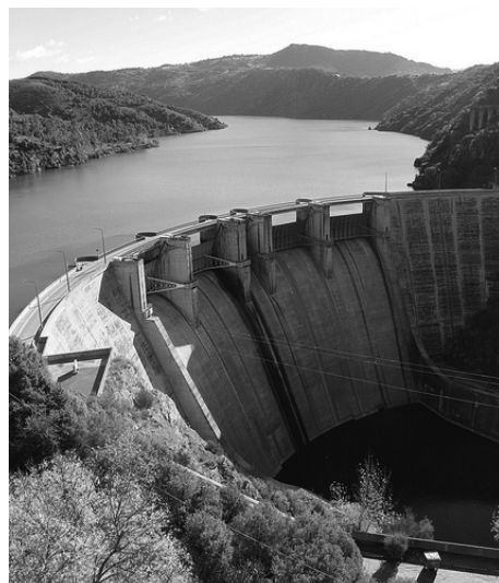
Fig 81. Barragem de Bemposta.
