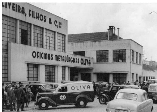
Fig 66. Fábrica OLIVA – Entrada da fábrica.
