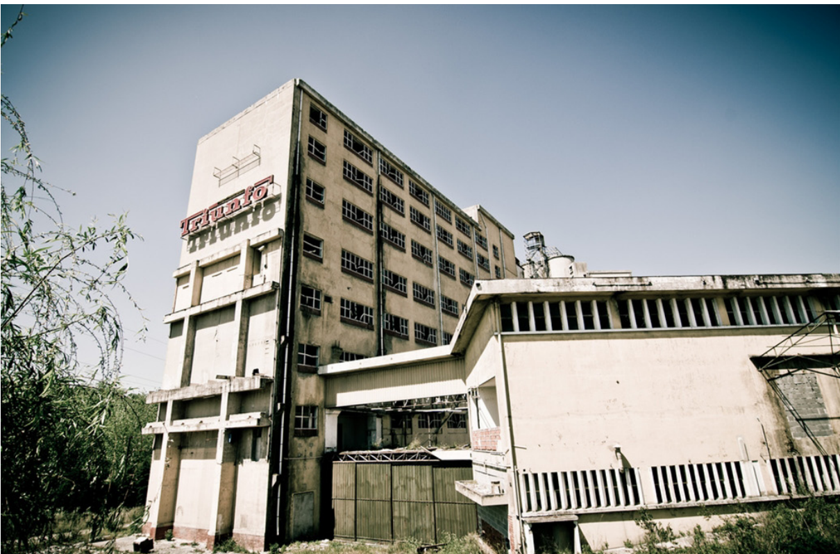
Fig 128. Actual estado da Fábrica Triunfo, Coimbra.
