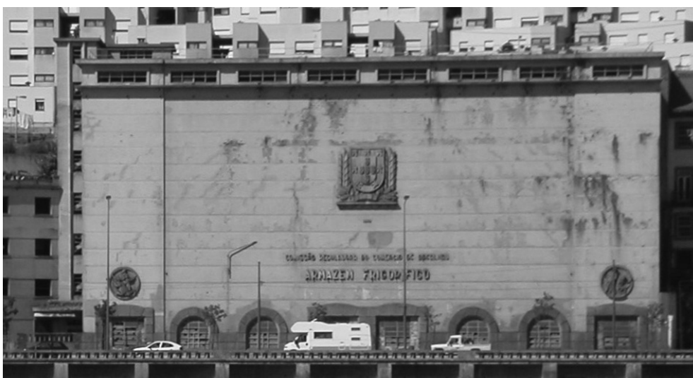
Fig 190. Alçado Sul do corpo principal antes da intervenção.
