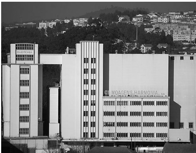
Fig 84. Companhia de Moagens Harmonia – Vista geral.
