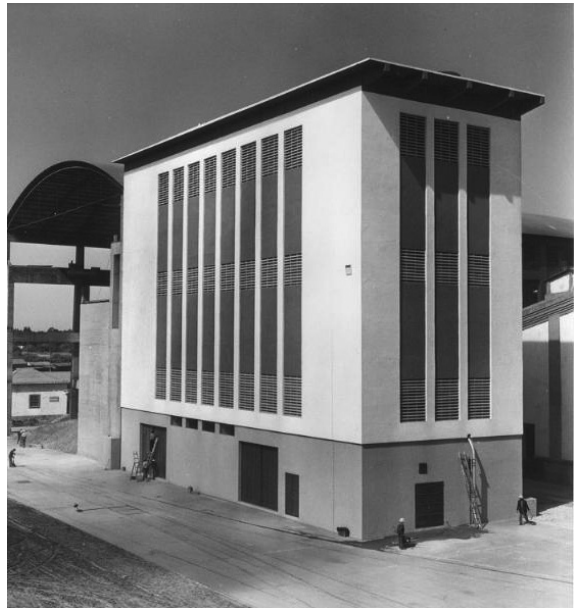
Fig 110. Fábrica de cimento Maceira-Liz – Edifício de moagem 7.
