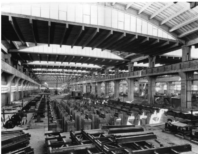
Fig 88. Siderurgia Nacional – Interior da nave de laminagem.
