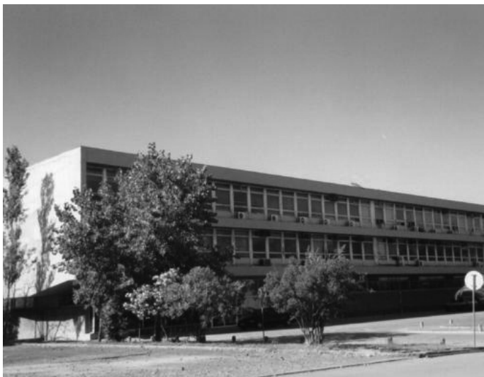
Fig 90. Siderurgia Nacional – Edifício administrativo.
