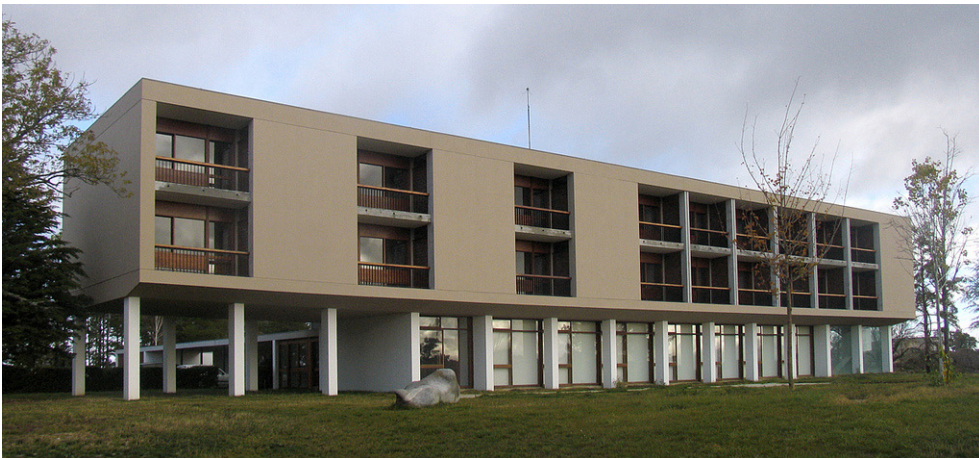
Fig 297. Vista do alçado Norte após a intervenção na Pousada de Picote.
