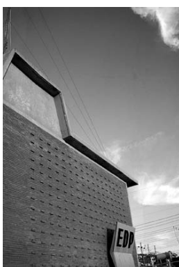
Fig 47. Subestação da UEP de Sobreda.
