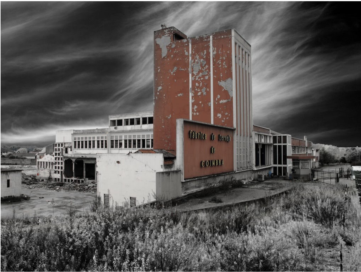
Fig 121. Actual estado da Fábrica de Cervejas de Coimbra.
