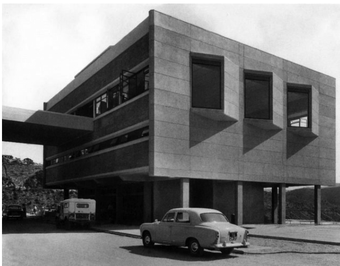
Fig 80. Edifício de Comando e Descarga de Bemposta.
