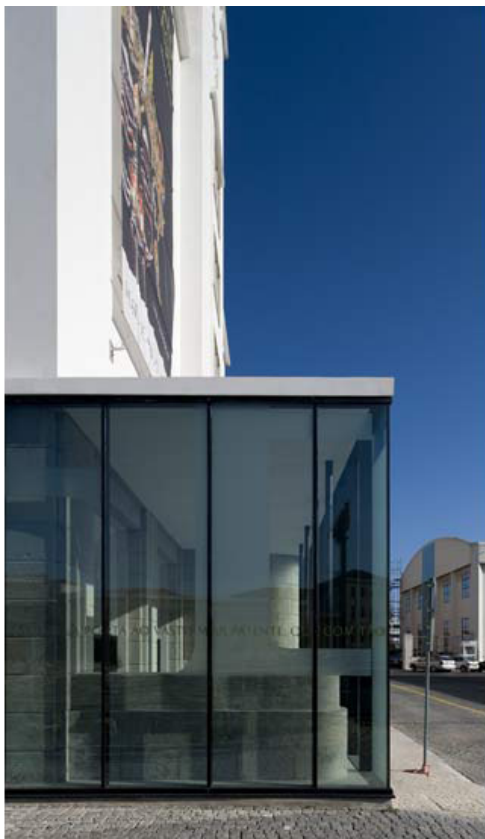
Fig 244. Pormenor do novo embasamento envidraçado.
