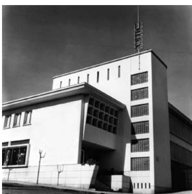
Fig 46. Subestação da UEP de Almada.
