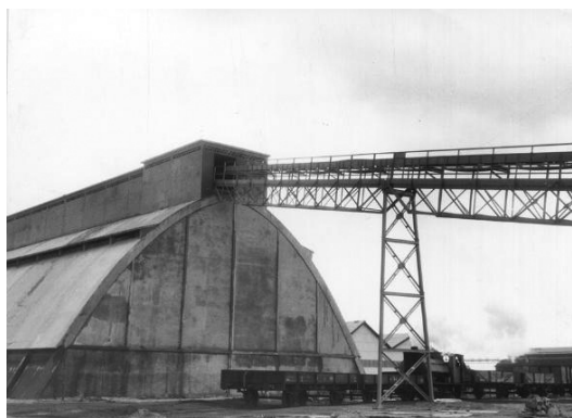
Fig 71. CUF – Silo de enxofre.
