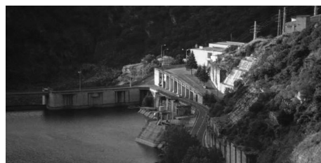
Fig 79. Barragem de Miranda.
