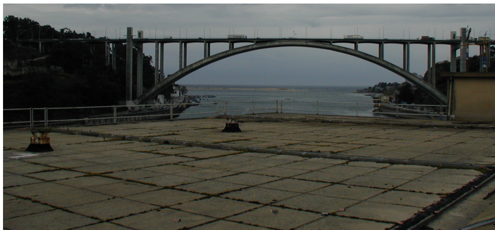
Fig 170. Vista a partir da cobertura em terraço.
