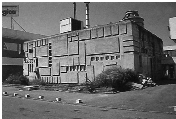
Fig 116. Kodak Portuguesa – Edifício das caldeiras.
