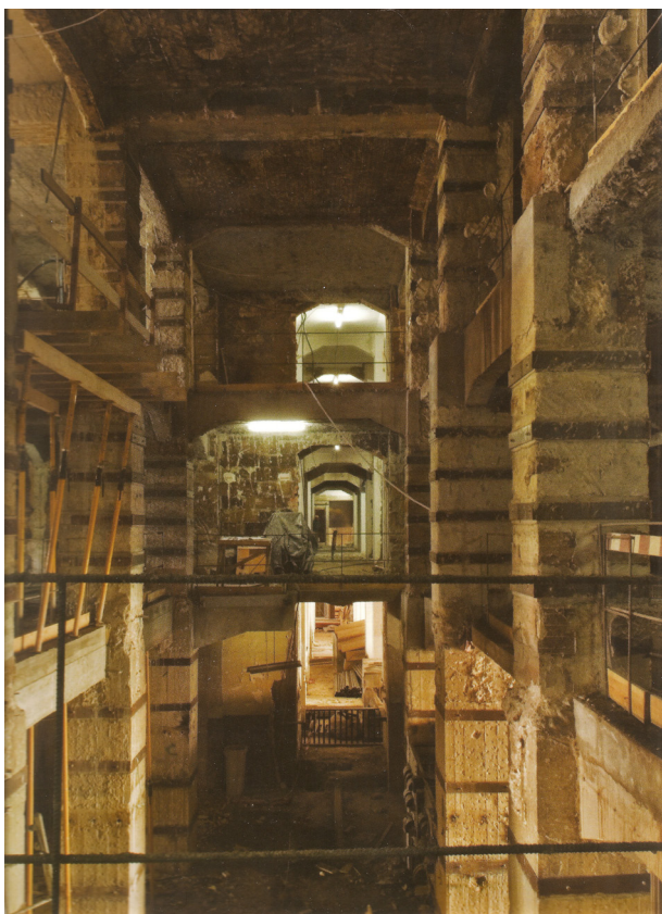
Fig 237. Vista interior durante o decorrer da obra.
