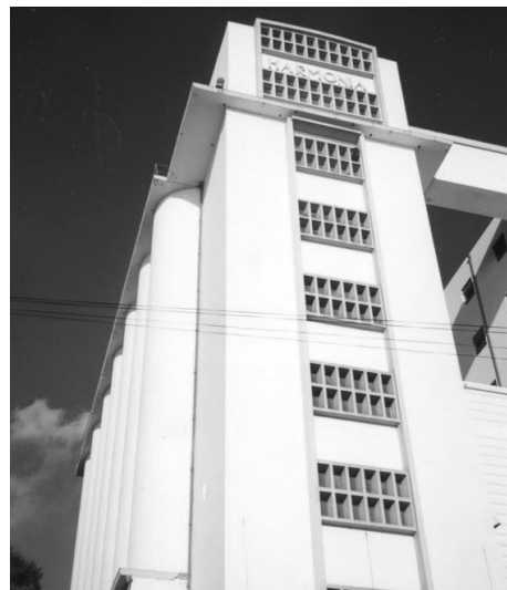
Fig 85. Companhia de Moagens Harmonia - Silos.
