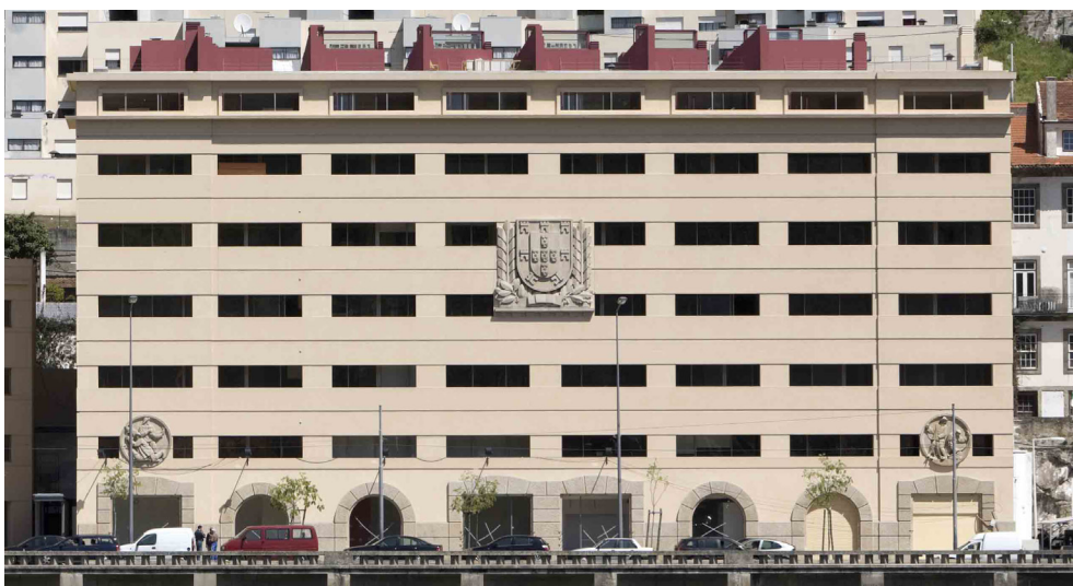
Fig 191. Alçado Sul do corpo principal após a intervenção.
