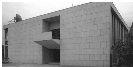
Fig 78. Edifício de Comando e Descarga de Miranda.
