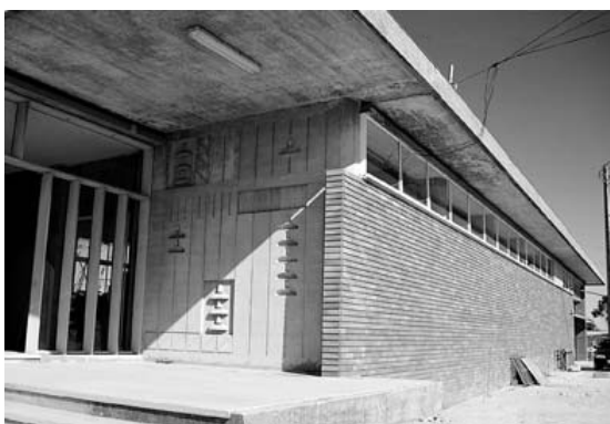
Fig 48. Subestação da UEP de S. Francisco.
