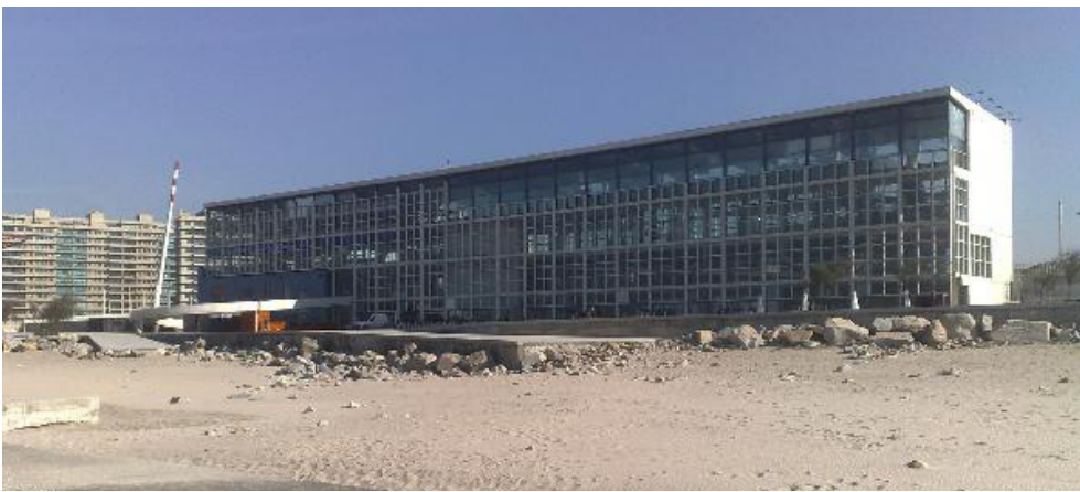
Fig 205. Edifício Transparente após a intervenção - vista exterior.
