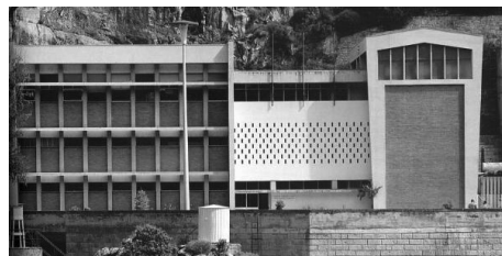
Fig 75. Edifício de Comando e Descarga de Picote.
