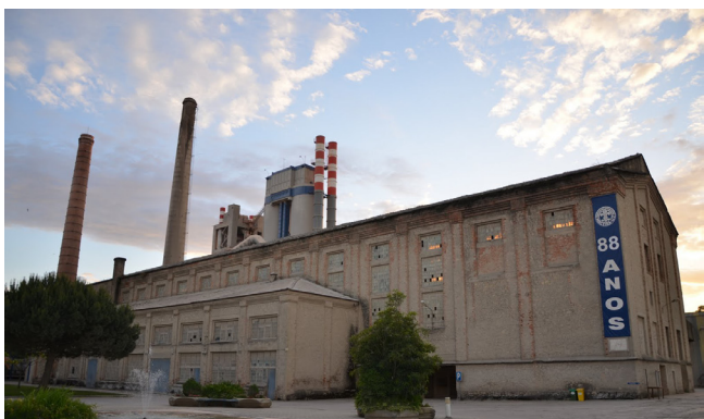
Fig 137. Museu do Cimento na Fábrica de Maceira-Liz - Vista exterior.
