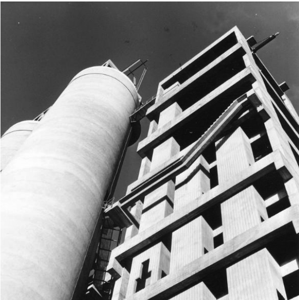
Fig 109. Fábrica de cimento Maceira-Liz – Ciclones do forno de cimento.
