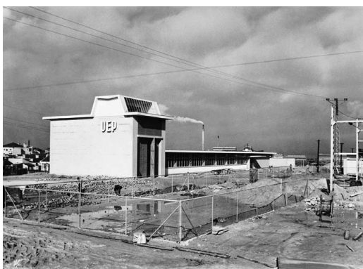
Fig 49. Subestação da UEP do Barreiro.
