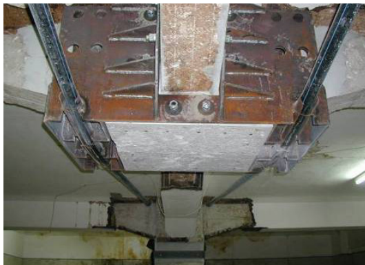
Fig 239. Mecanismo de reforço estrutural.
