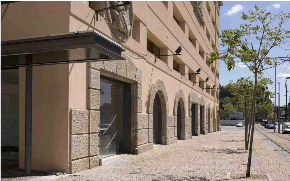
Fig 192. Piso térreo após a intervenção.
