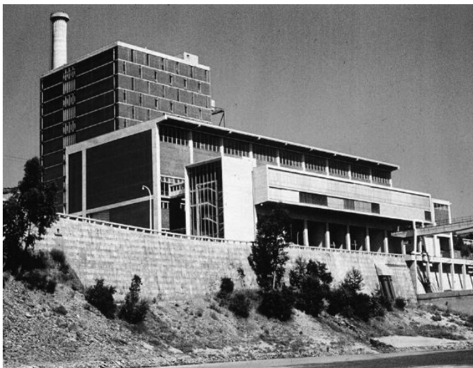
Fig 82. Central Termoelétrica da Tapada do Outeiro – Vista geral.
