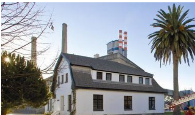
Fig 139. Museu do Cimento na Fábrica de Maceira-Liz - Vista exterior.
