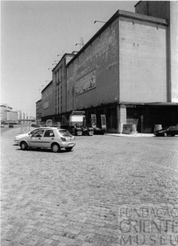
Fig 220. Vista do Armazém Frigorífico do Bacalhau de Lisboa antes da intervenção (Norte).
