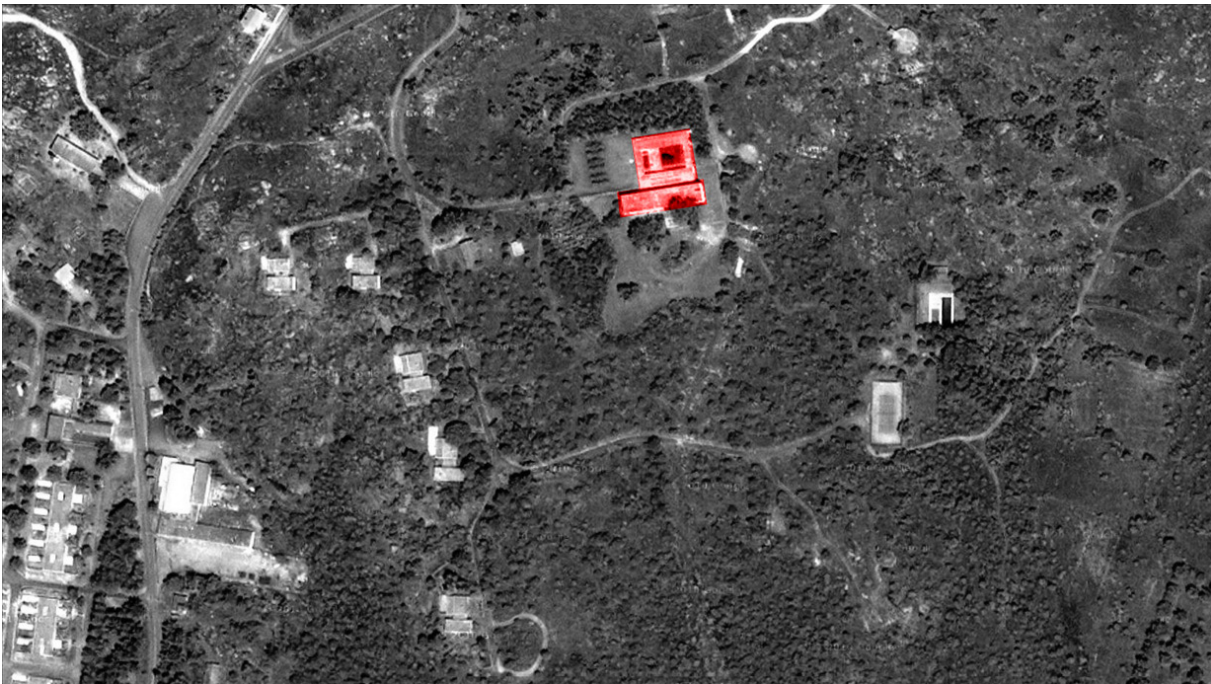
Fig 263. Vista aérea da implantação da Pousada do Aproveitamento Hidroeléctrico do Douro Internacional de Picote.
