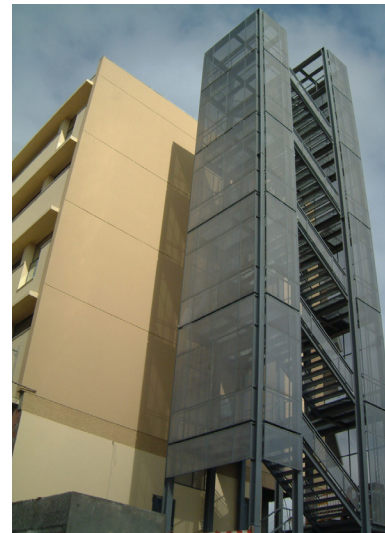
Fig 149. Nova sede da RTP (antiga DIALAP) - Novas escadas exteriores.
