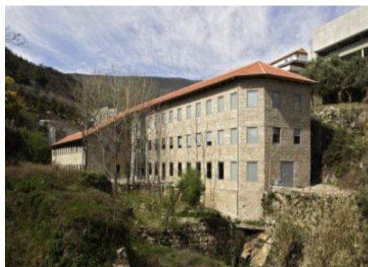
Fig 133. Museu de Lanifícios da Universidade da Beira Interior - Vista exterior.
