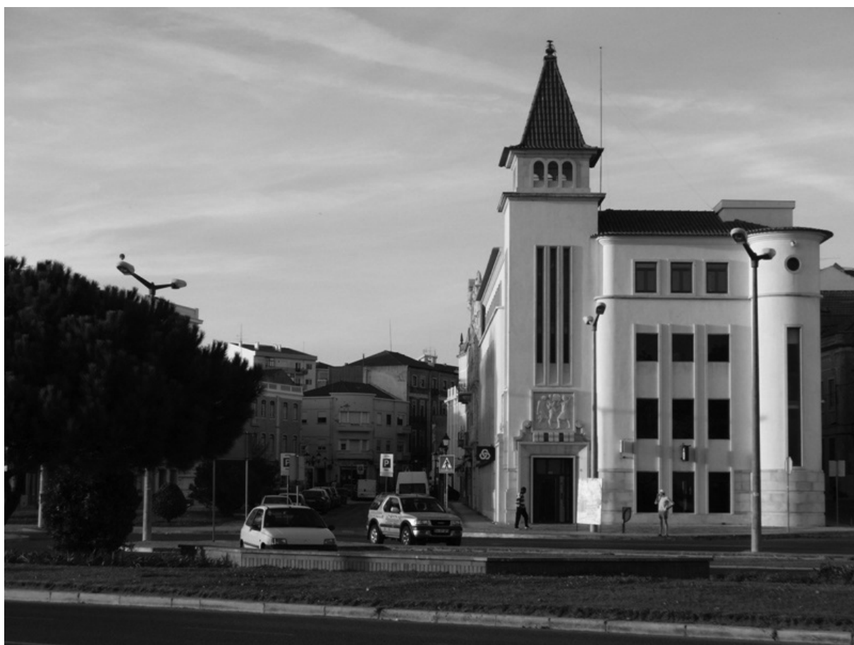
Fig 209. Caixa Geral de Depósitos da Figueira da Foz da autoria do Arq. João Simões.
