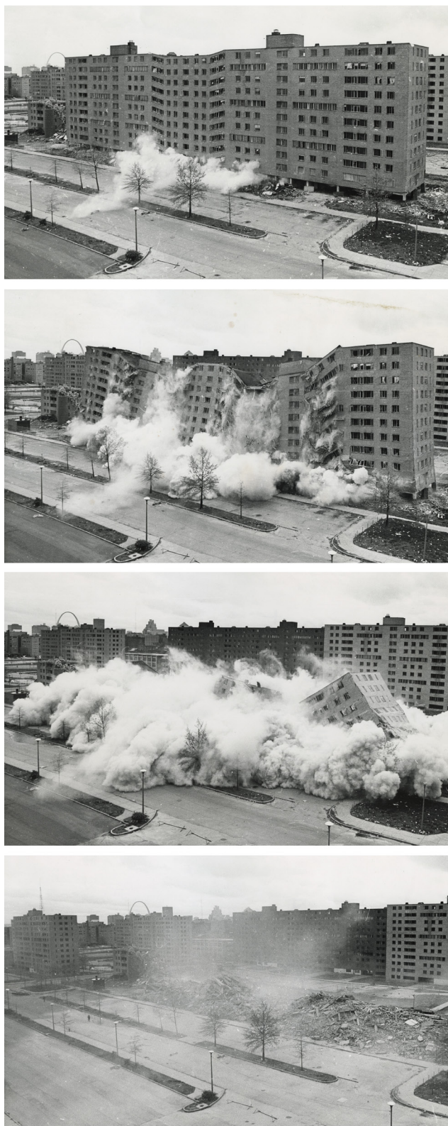
1.2 Demolição do complexo Pruitt-Igoe - Um marco simbólico do fim dos ideais da arquitetura moderna
