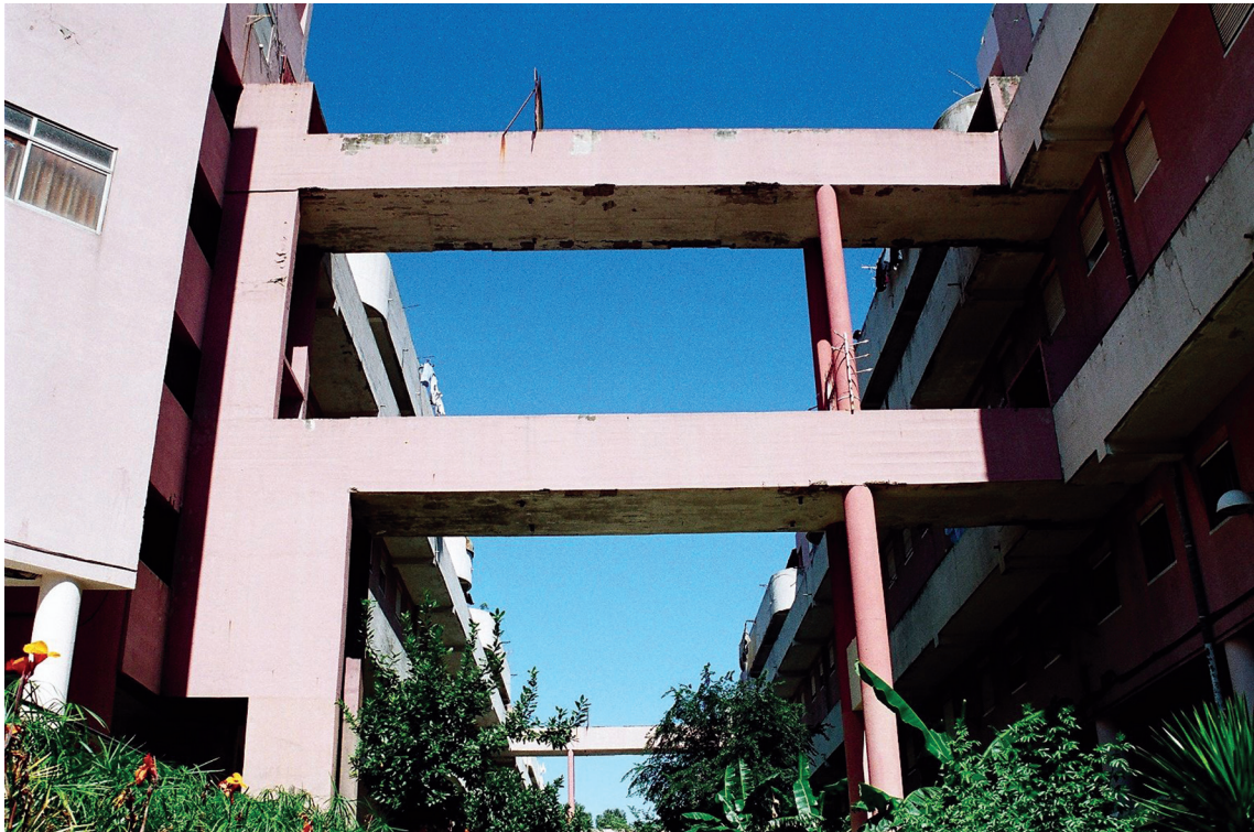
35 | Edifício Pantera Cor-de-Rosa de Gonçalo Byrne, 1971-75.
