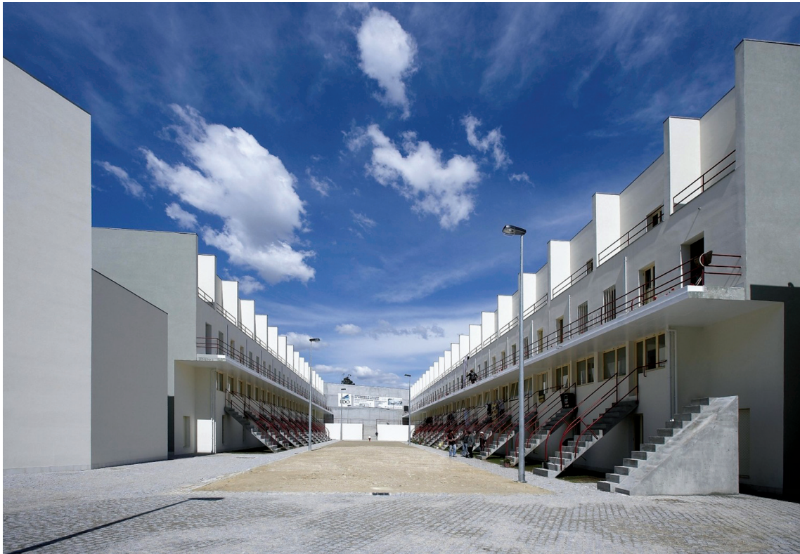
42 | Bairro da Bouça de Alvaro Siza Vieira.
