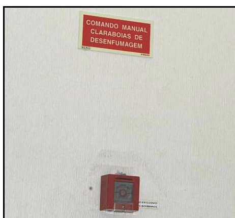
Figura 4.8 – Comando Manual das Clarabóias da Desenfumagem. Foto: Mário Rui.
