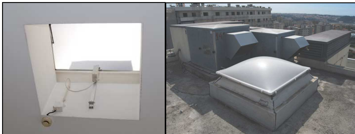
Figura 4.3 – Exutor de Fumos no Topo das Caixa de Escadas (Artº 35º DL 64/90). Fotos: Mário Rui.
