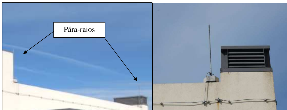
Figura 4.13 – Protecção contra Descargas Atmosféricas (Artº 74º do DL 64/90).
