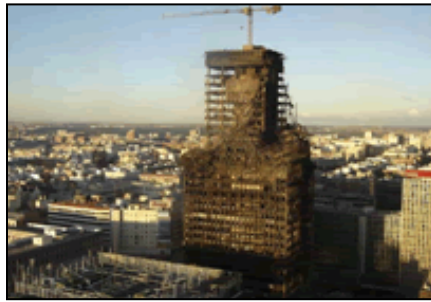
Figura 1.3 – Edifício após o Incêndio. Foto: Fernando Lamarca
