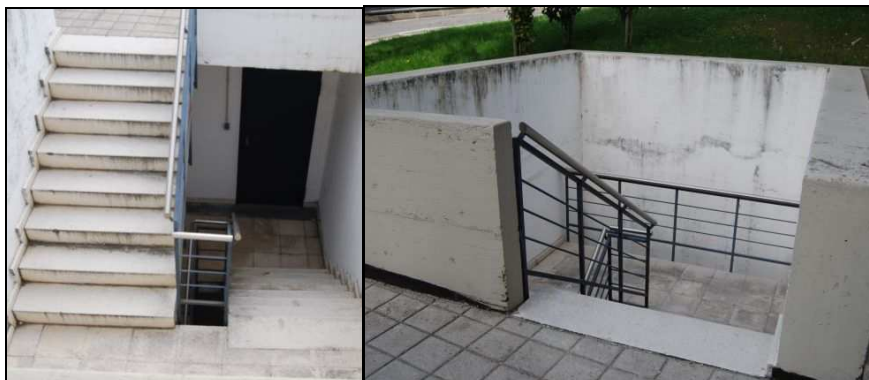
Figura 4.9 – Saída de Emergência do Estacionamento. Fotos: Mário Rui.
