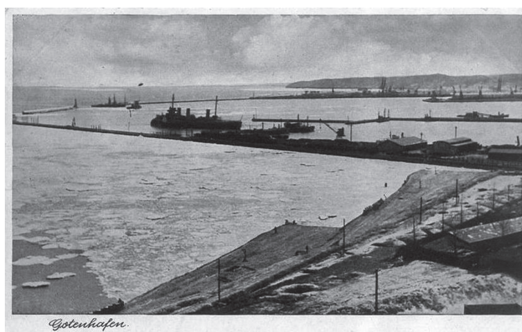
Fig. 4 – Postal com vista parcial do porto de Gotenhafen, no Inverno. Colecção do autor.
