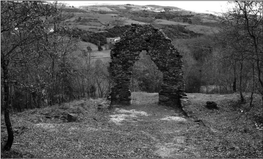
Fig. 1 – Ruínas da ermida da invocação de Nossa Senhora da Hedra. As casas que se vislumbram atrás são da aldeia de Cova da Lua. Foto gentilmente cedida por Armando Redentor.
