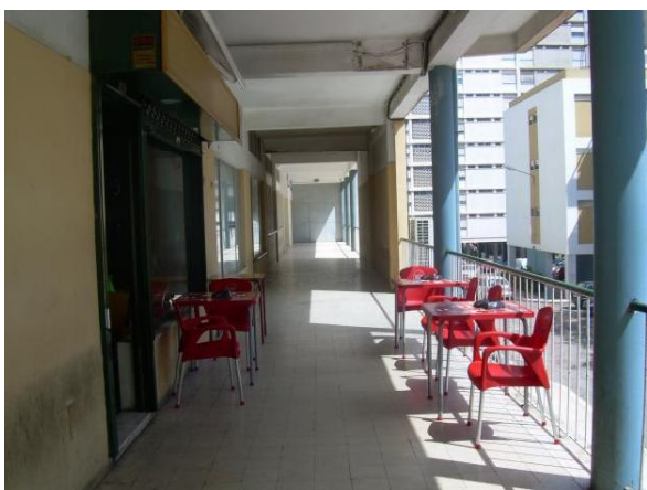
fig. 83 | Galeria de acesso e distribuição em Olivais Norte fonte: http://lisboacity.olx.pt/trespasse-de-cafe-olivais-norte-iiid-43305462
