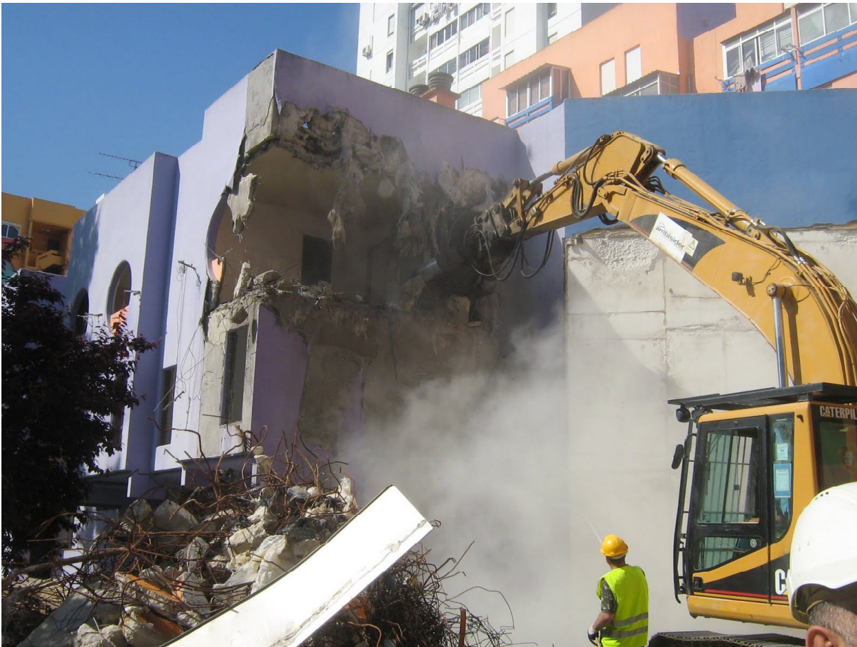
fig. 148 | Demolição de edifícios devolutos na Zona J, 2009 fonte: http://naohaquemnosdefenda.blogspot.com/2010_07_01_archive.html
