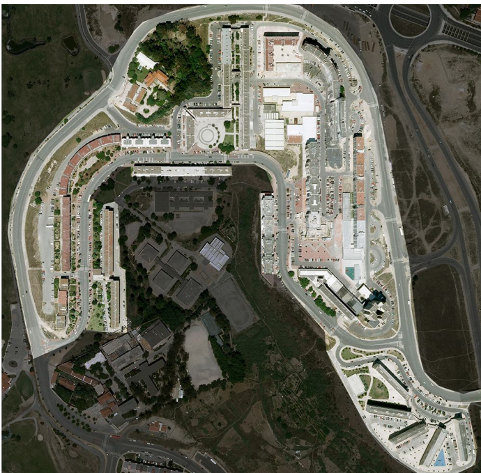
fig. 72 | Zona N2, Bairro das Loias fonte: Google Maps
