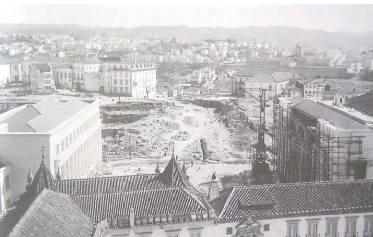
Fig. 65 – Alta em demolição com a abertura da nova Rua Larga.
