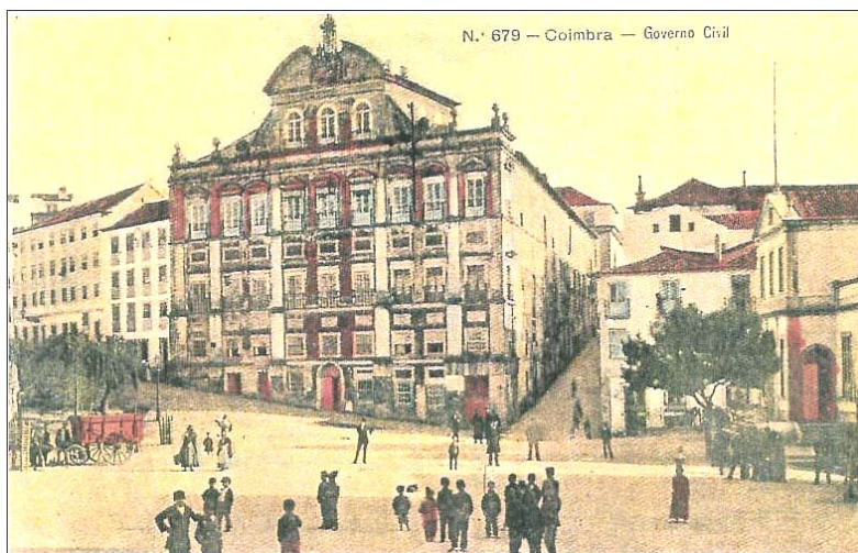
Fig. 32 - Colégio de S. João Evangelista, fachada ao Largo da Feira.
