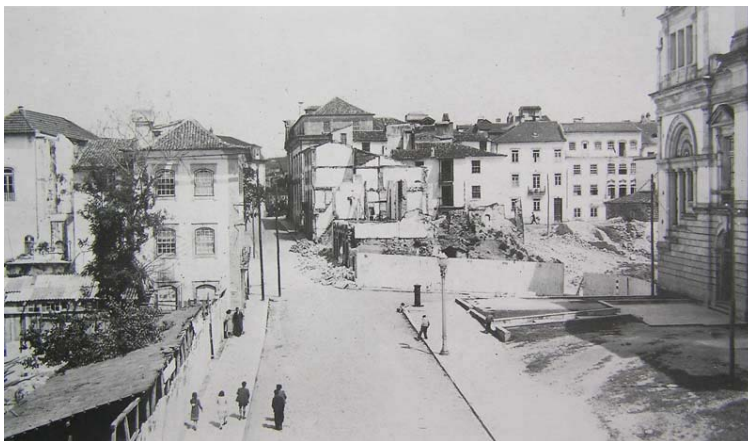
Fig. 60 – Rua Larga, já em obras de demolição.
