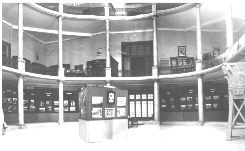
Fig 48 – Aspecto da sala central da Faculdade de Letras do Arq.º Silva Pinto
