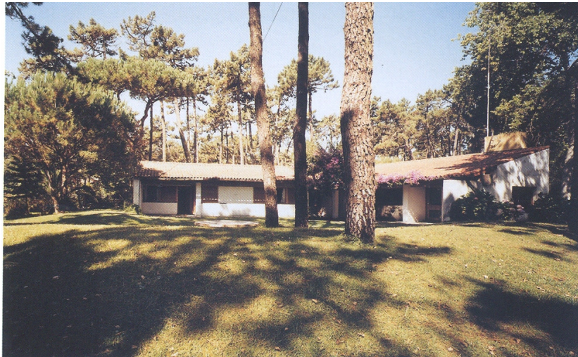
fig. 22 - Casa em Ofir de Fernando Távora
