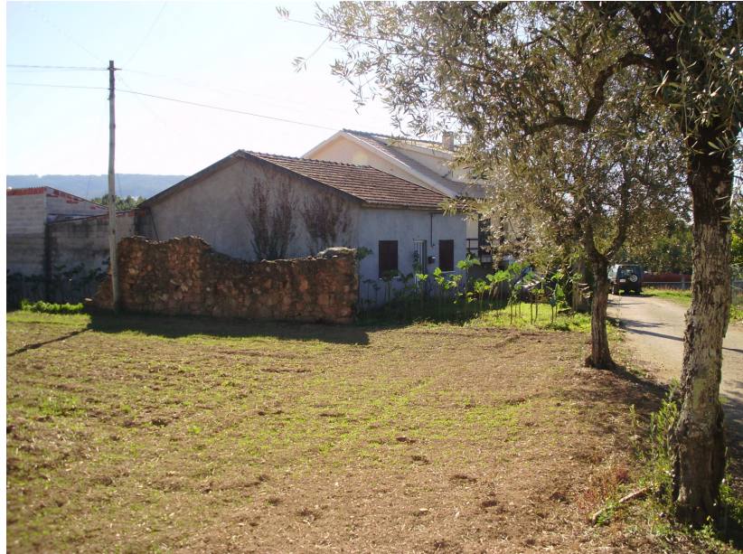
fig. 19 – Muro de pedra no limite Noroeste do terreno
