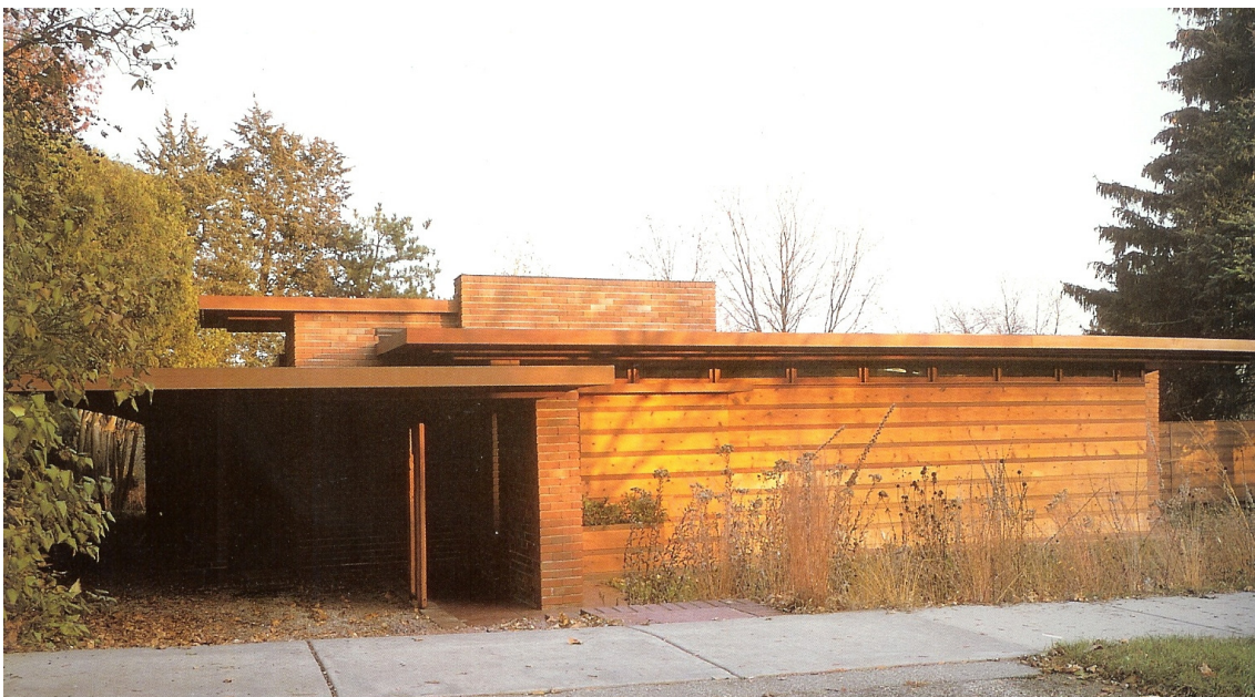
fig. 27 - Fachada da casa Jacobs - Frank Loyd Wright
