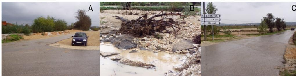
O pavimento alcatroado foi também destruído como se vê na fotografia B. A dimensão e quantidade dos sedimentos transportados e depositados nos solos agrícolas aluviais (fotografias B e C) evidencia a elevada energia hidrodinâmica associada a este evento<sup>50</sup>.
