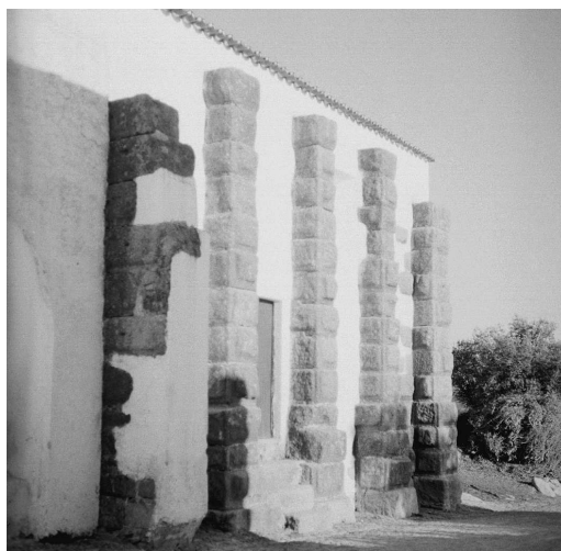
Fig. 2 – Pormenor da igreja actual, sendo visíveis pedras aparelhadas claramente de época romana.
