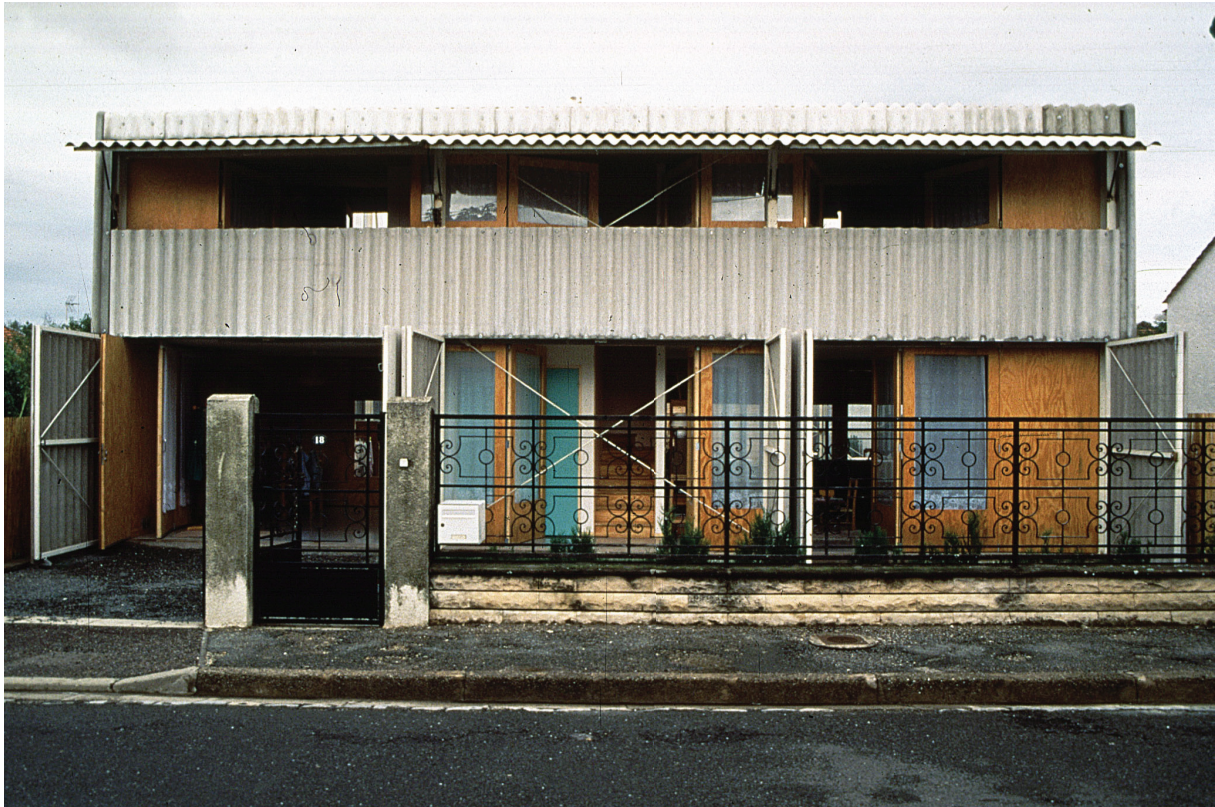
Fig.60 Vista da fachada da CASA LATAPIE com as portadas abertas, do volume revestido em placas de fibrocimento, e evidenciando o volume interior, em placas de madeira contraplacada
