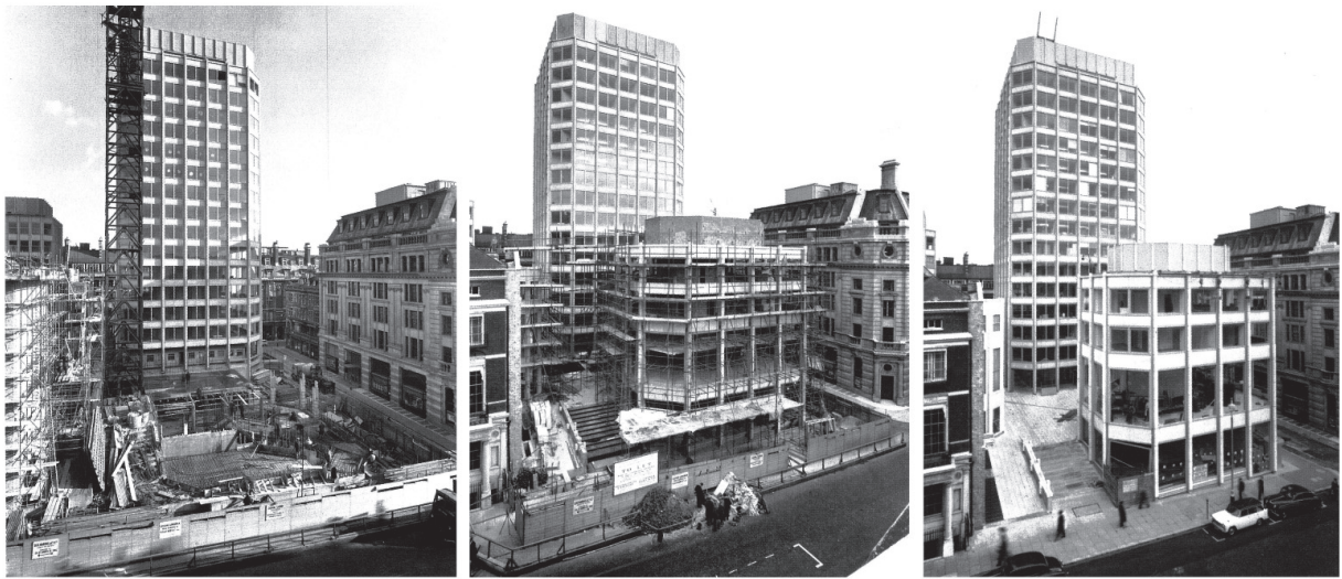
Fig.14, 15, 16 (da esquerda para a direita) Fases da construção do THE ECONOMIST BUILDING, de Alison & Peter Smithson, 1959-1964
