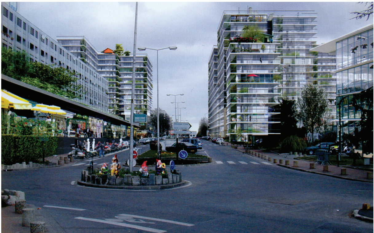
Fig. 55, 56 (do topo para baixo) O antes e o possível depois, da aplicação do método proposto, nos blocos de habitação em Aulnay-sous-Bois
