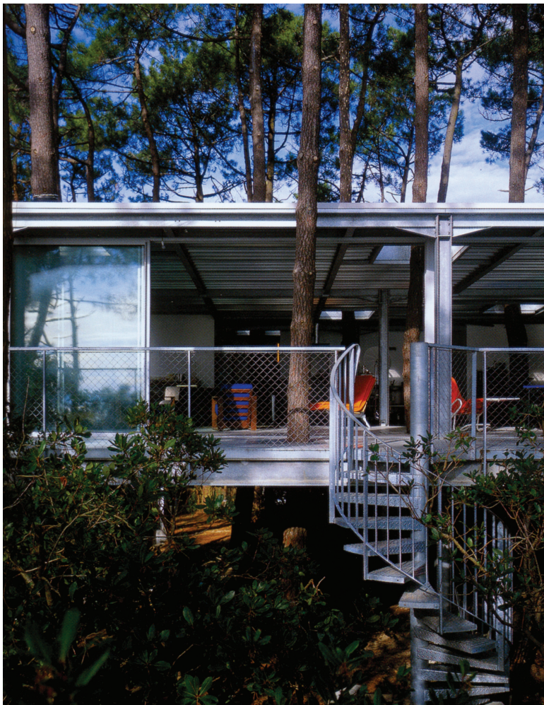
Fig.21 Vista exterior da CASA EM CAP FERRET, de frente para as escadas de acesso
