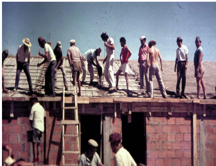
Fig.28 Processos de autoconstrução, operação SAAL Algarve, Lagos.
