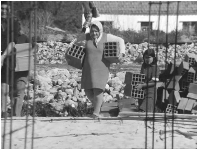
Fig.29 Processos de autoconstrução, operação SAAL Algarve, Lagos.
