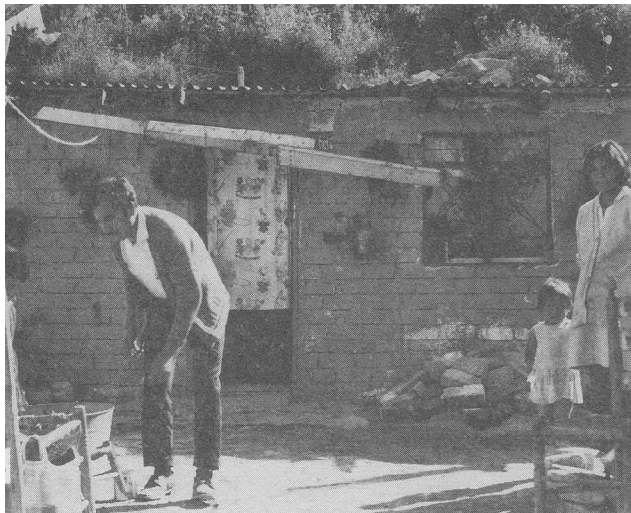
Fig.09 Morador, construindo a sua própria casa, cidade do México.
