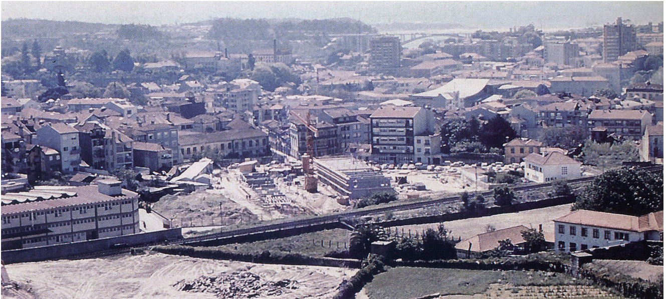
Fig.43 Bairro da Bouça em construção.
