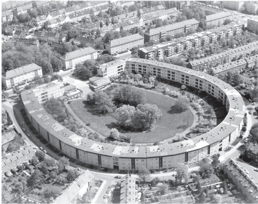
Fig.46 Großsiedlung Britz (Hufeisensiedlung) de Bruno Taut. Berlim (Alemanha), 1925/30.
