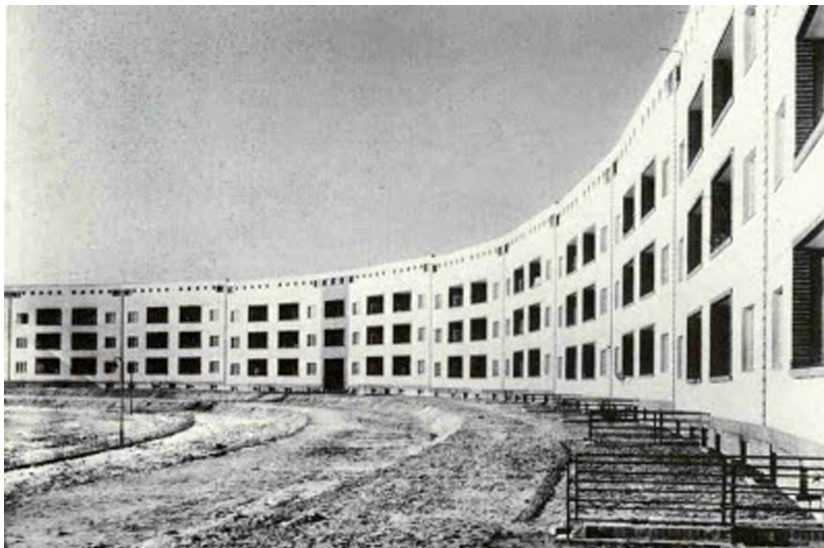
Fig.47 Großsiedlung Britz (Hufeisensiedlung) de Bruno Taut. Berlim (Alemanha), 1925/30.
