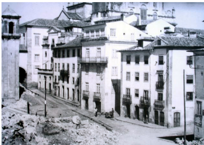
FIG. [31A e 31B] Início das obras para a Cidade Universitária. Vista aérea da Alta e vista da antiga Rua Arco do Castelo, final da primeira metade do século XX.
