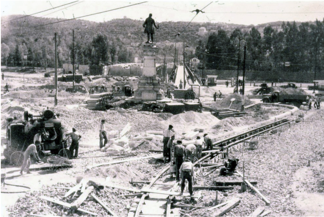
FIG. 15 Colocação dos carris no Largo da Portagem, Coimbra, 1910.
