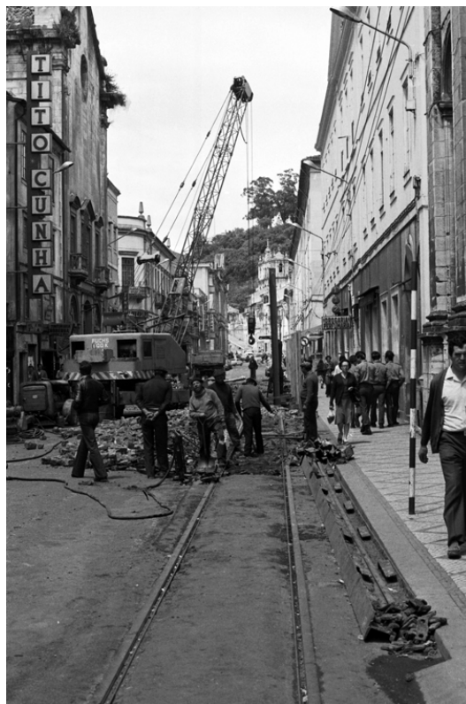
FIG. 39 Obras de retirada dos carris da Rua da Sofia, anos 70.
