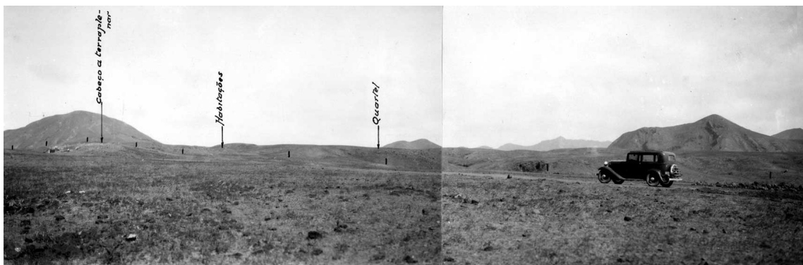
Reconhecimento do local onde deveria ser construída a colônia
