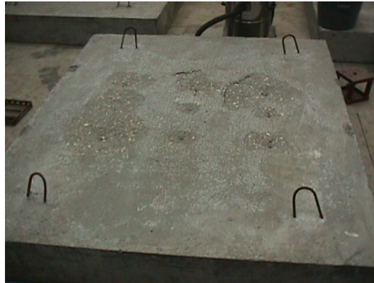
Figura 4.7 – Aspecto de uma laje de ensaio.
