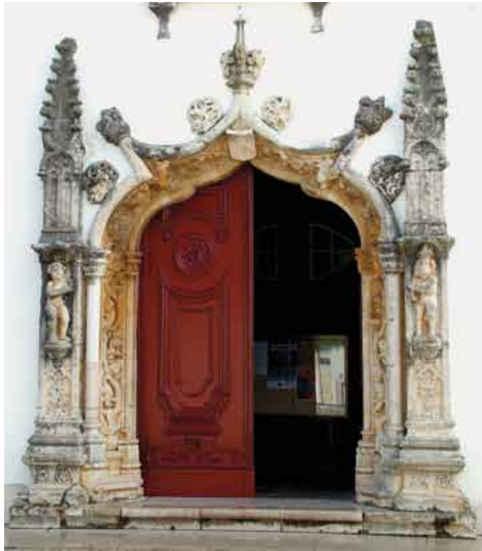
Portal da Igreja Matriz de Arruda dos Vinhos
