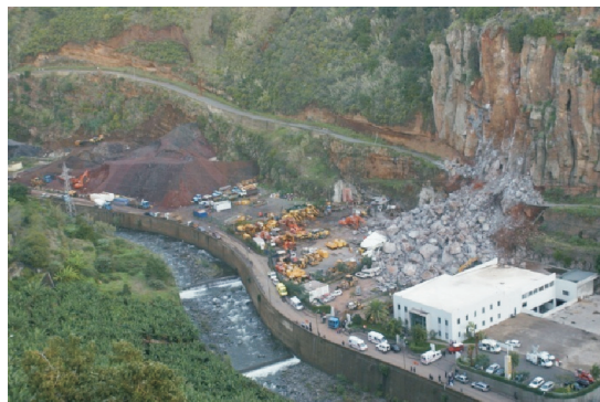
Fot. 5 - Desabamento no vale encaixado da Ribeira dos Socorridos (ABREU, 2007).
