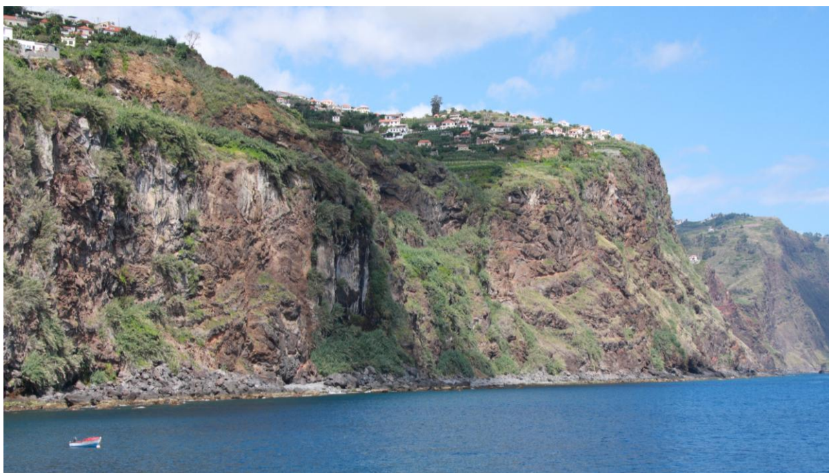
Figura 39 - Vista do litoral sul do concelho entre a Ribeira Brava e Campanário.
