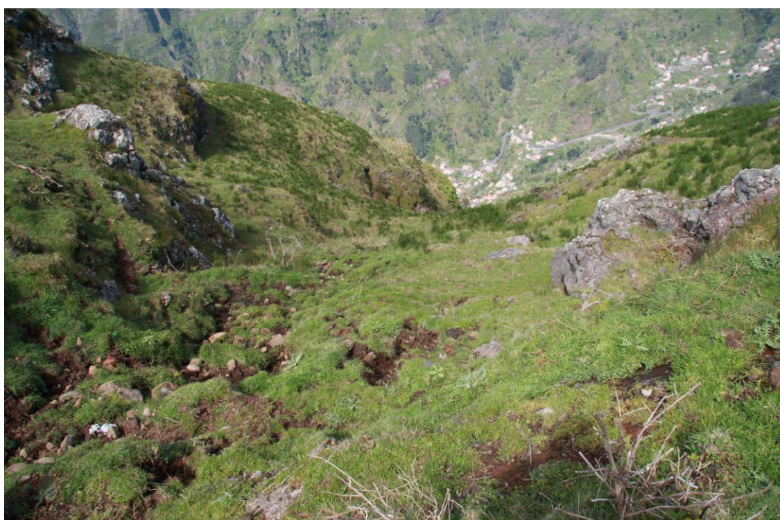
Figura 9 - Solo desprovido de vegetação e com traços de erosão (Trompica).
