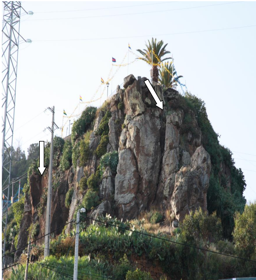
Figura 52 – Disjunção em colunas e blocos de escoada lávica com fracturação acentuada, evidenciando algumas colunas sinais de tombamento, no lugar “Cima da rocha”, freguesia do Campanário.
