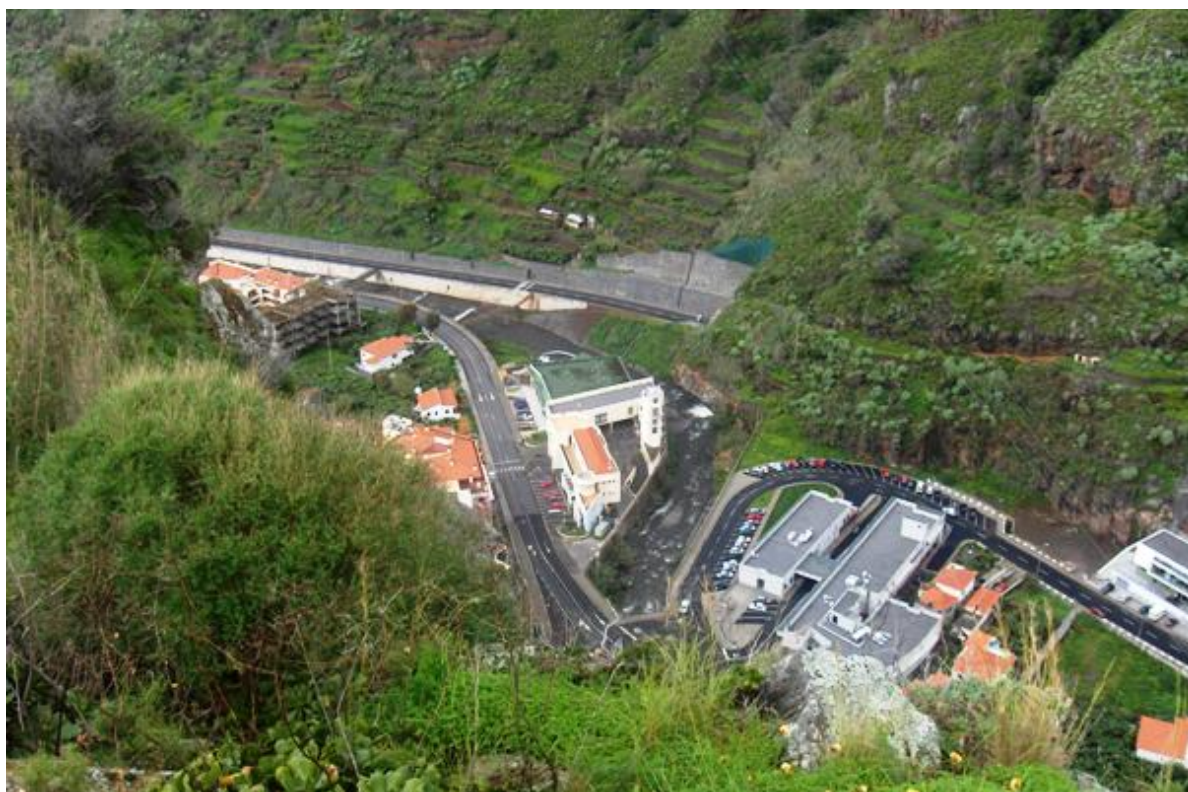
Figura 99 – Vista de elementos vulneráveis a movimentos de vertente na encosta Oeste da ribeira Brava
