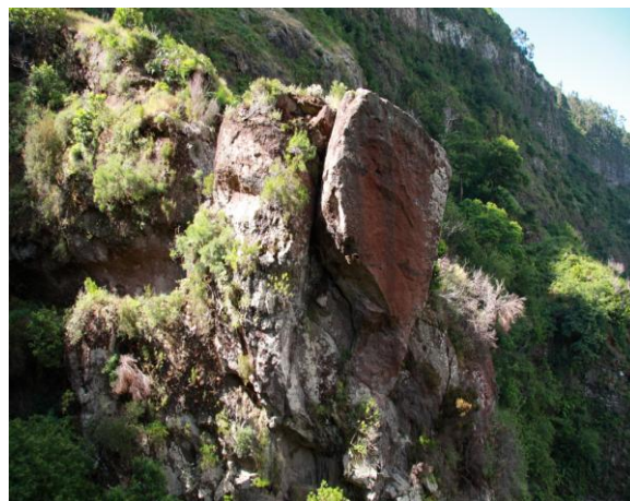
Figura 65 – Área de desprendimentos de blocos na encosta a Este da ribeira da Ribeira Brava
