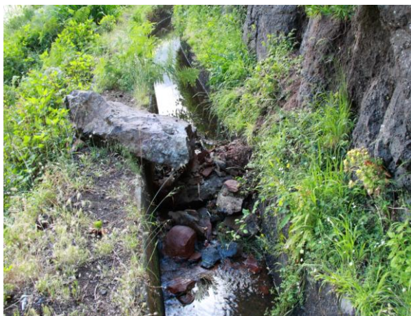
Figura 64 – Queda de Blocos no Curso da Levada do Norte, interrompendo o Seu Curso.
