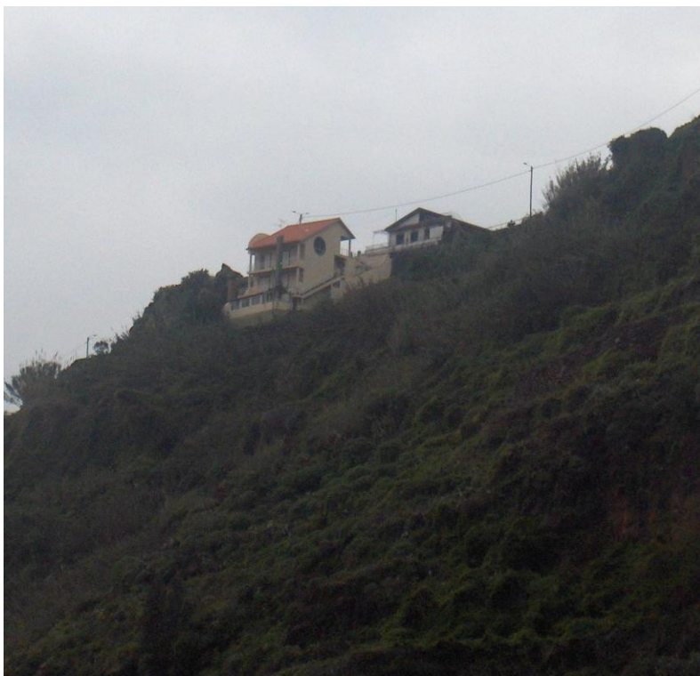
Figura 96 – Casa no cimo da encosta, exposição elevada ao risco, tendo como elemento vulnerável a habitação e seus ocupantes.
