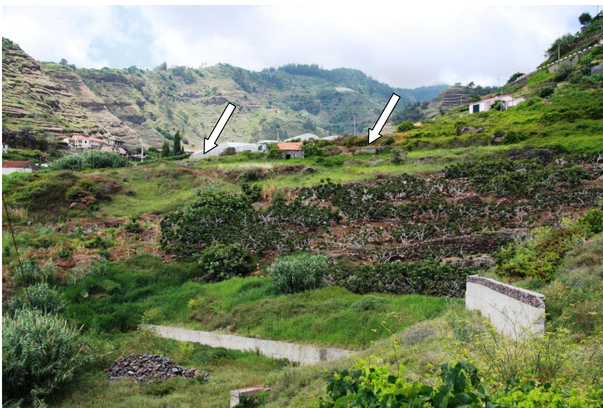
Figura 74 – Vista parcial do movimento de massa da Tabua, área de queda de muros e de abatimento de terrenos.
