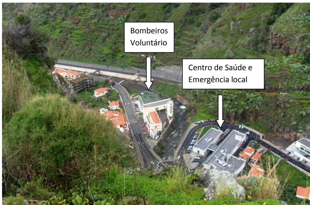
Figura 108 – Vista de elementos vulneráveis a movimentos de vertente na encosta Oeste da ribeira Brava.
