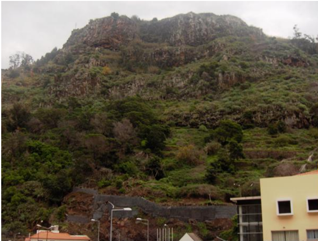
Figura 100 – Área de elevada susceptibilidade a movimentos de vertente, com elevada vulnerabilidade na sua base.
