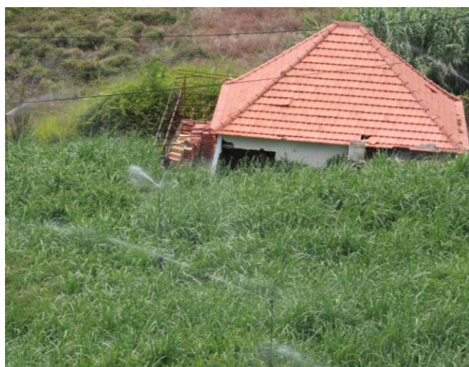
Figura 73 – Sistema automático de rega instalado nos terrenos em redor da casa.
