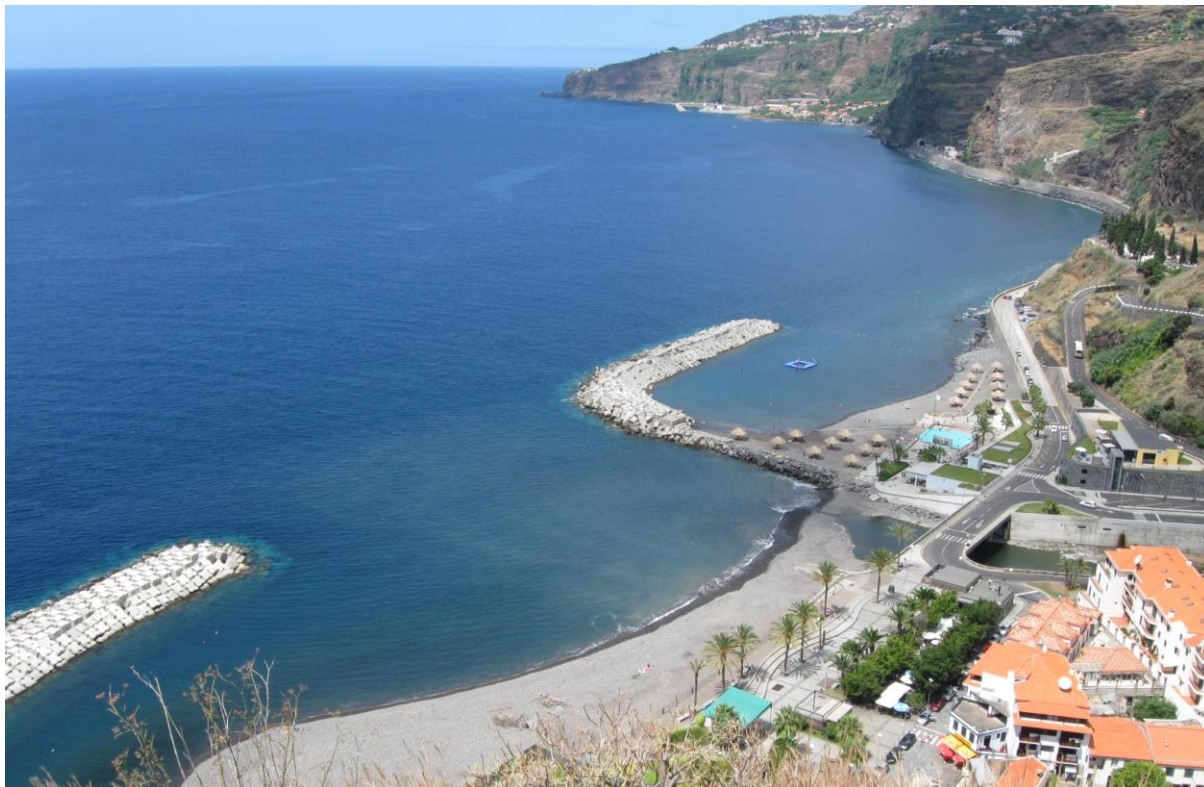
Figura 105 – Vista da faixa litoral do lugar da vila e respectivos enrocamentos de protecção do lugar.
