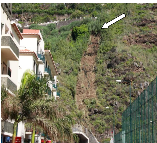
Figura 90 – Fluxo de detritos na encosta Oeste do vale da Ribeira Brava
