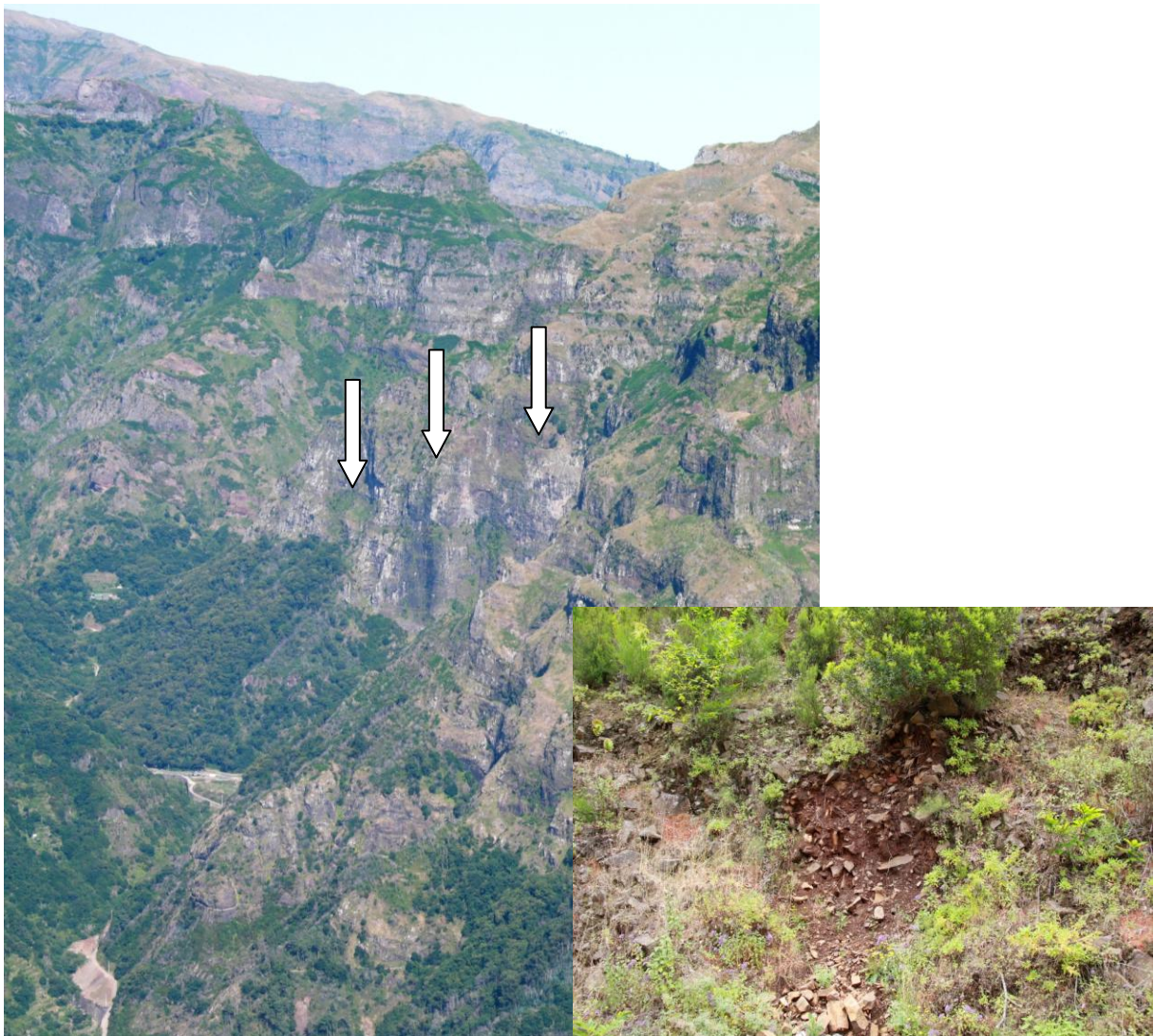
Figura 61 - Vista do talude subvertical que ascende aos 200 m de altura, na Serra de Água, junto à Estação de Distribuição de Água e pormenor do referido depósito.
