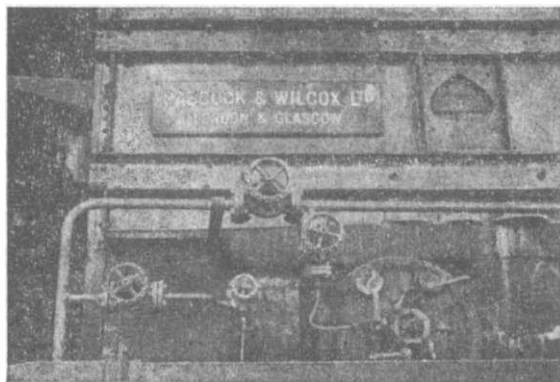
Fig. 7 — Pormenor de uma das caldeiras, do qual se destaca a respectiva marca (fot. de Varela Pêcurto).
