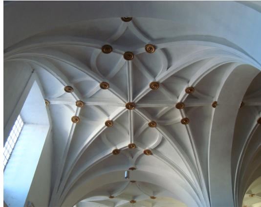
21. Módulo da abóbada de nervuras nos tramos da nave central
