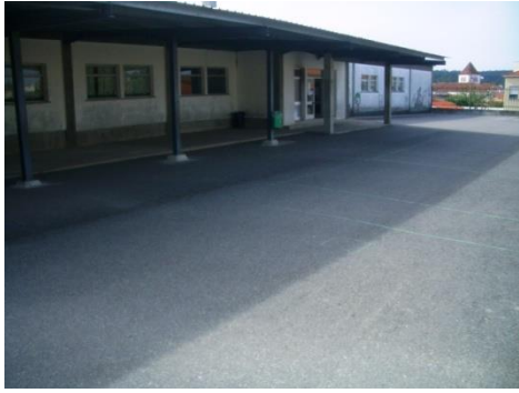
Figura 4 Pátio da parte de trás do segundo bloco da escola.
