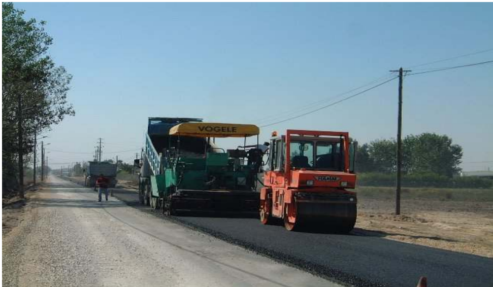
PAVIMENTAÇÃO DO CM 1027 – PINHAL NOVO CÂMARA MUNICIPAL DE PALMELA
