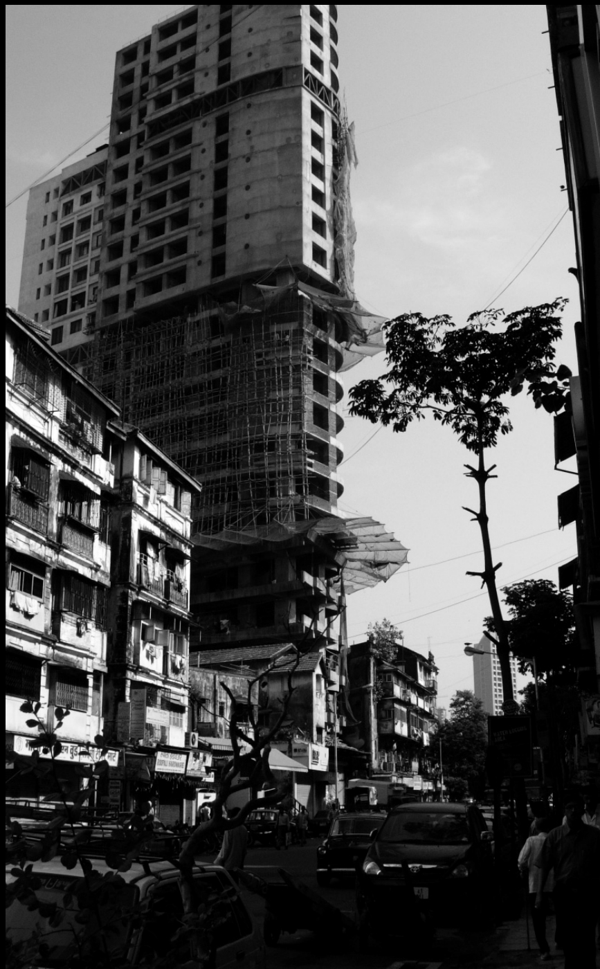
Nesta página: método de construção em bambu e corda de cânhamo.
