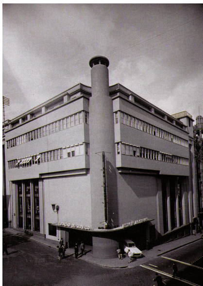
16 Garagem do Jornal "O Comércio do Porto" Porto, 1930 Arquitecto Rogério de Azevedo
