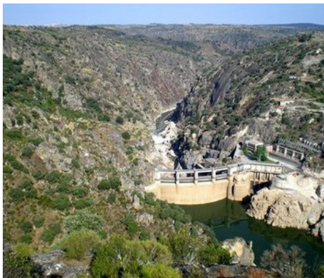
21 Rio Douro e Vista Geral da Barragem de Picote
