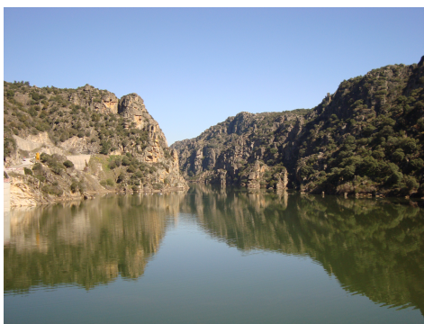
23 Rio Douro a Montante da Barragem
