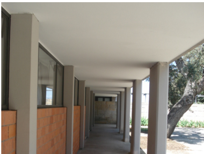
70Centro Comercial_Percurso coberto de acesso à entrada
