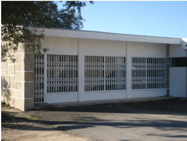
62 Escola Primária_Vista exterior sobre uma das salas de aula
