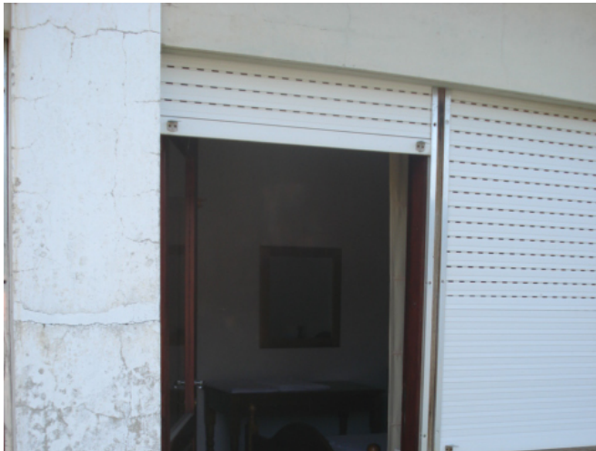
53 Casas do Pessoal Especializado_Acesso do quarto para o exterior
