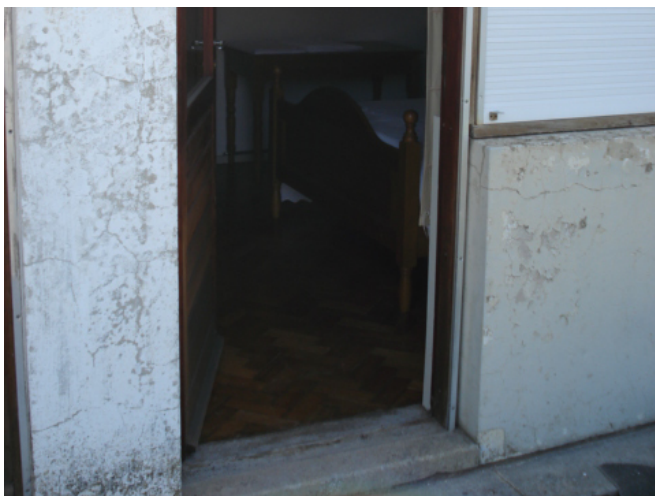
55 Casas do Pessoal Especializado_Acesso do quarto para o exterior
