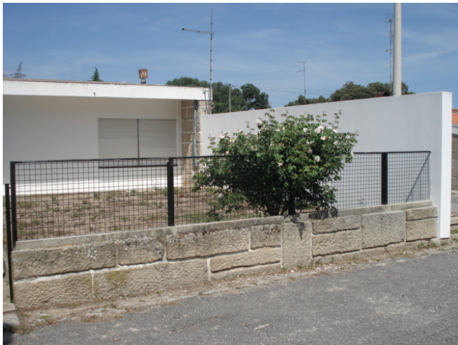
51 Casas do Pessoal Especializado_Vista do terraço a Nascente
