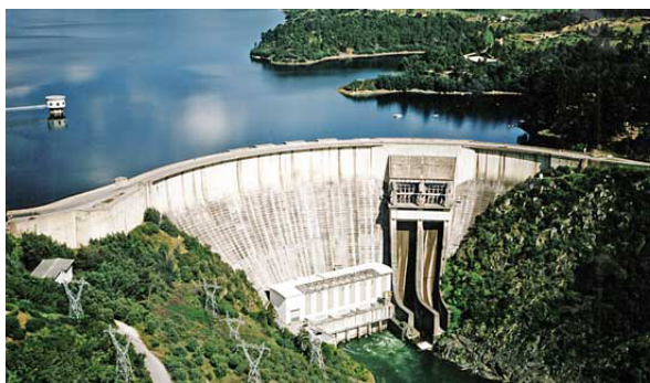
7 HEZ, Barragem de Castelo do Bode, 1946/51, Rio Zêzere
