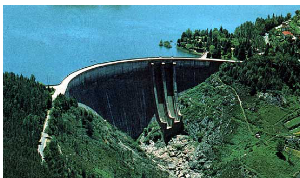
8 HICA, Barragem de Venda-Nova, 1945/51, Rio Cávado
