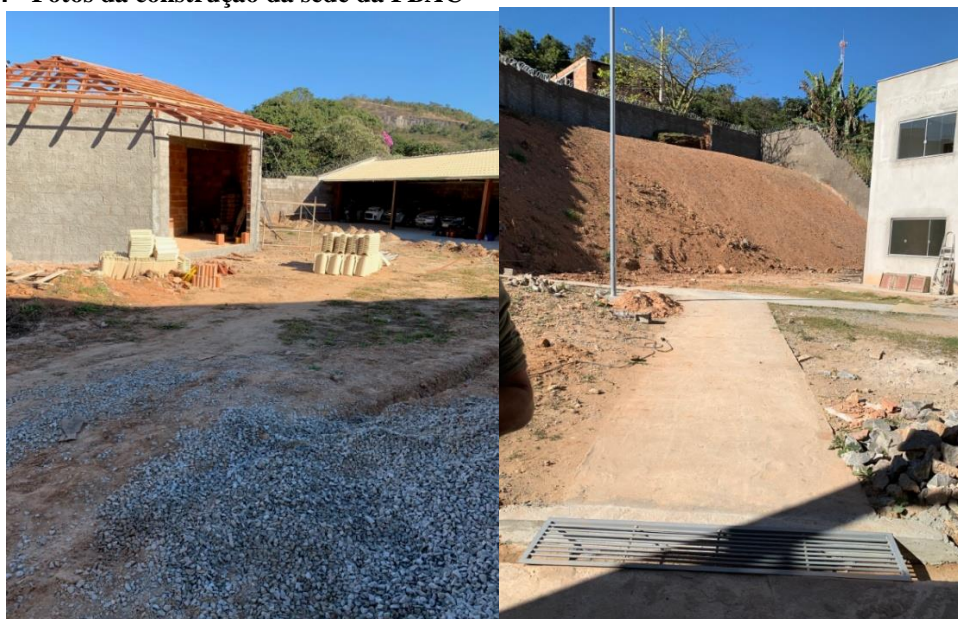
Figura 4 - Fotos da construção da sede da FBAC
