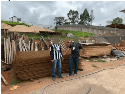
Figura 51 - Obra de ampliação da APAC
