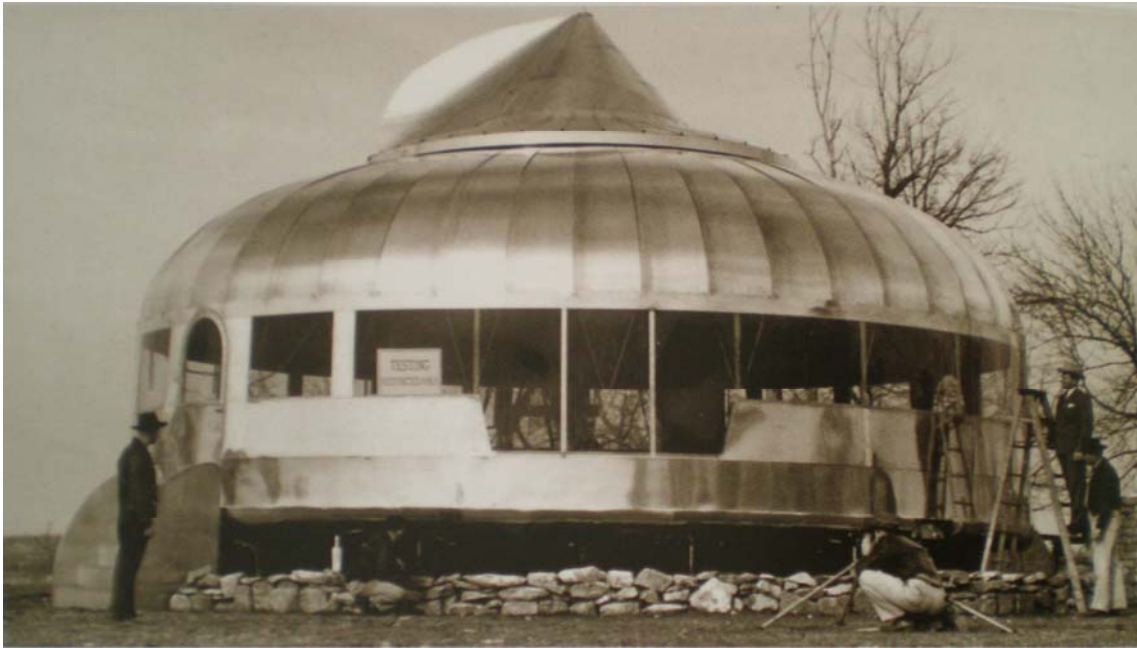
Fig.1. DDM, ainda numa fase de construção, 1946.
