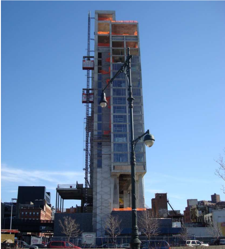
86| Novas construções junto à High Line. 2008.
