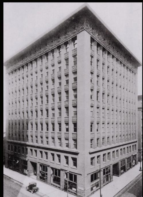
O *Home Insurance Building* (Fig.1), de 1885, é considerado o primeiro edifício de estrutura completamente metálica de Chicago, ainda que as paredes tenham um carácter resistente, que só perderiam em 1889 com o segundo *Leiter Building* (Fig.2) e o *Fair Building*, de Le Baron Jenney, o qual reduz as fachadas a cortinas de cerramento suportadas por estruturas metálicas interiores.
