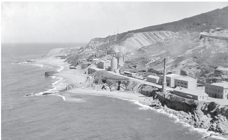
Fig. 7. Panorâmica das instalações fabris e pedreiras do Cabo Mondego, em finais dos anos 1940. Em primeiro plano, sobre as arribas com calcários e margas do Jurássico Superior, os edifícios de ensacamento e armazenamento da cal hidráulica e cimento e a chaminé da antiga fábrica de vidro; em segundo plano os fornos e a pedreira da cal; em último plano, a pedreira Norte, do cimento (coleção J. M. Soares Pinto).
