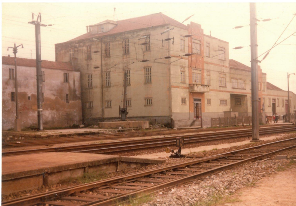
Figura 6 – Foto da Hidro-Eléctrica , vista da linha do comboio
