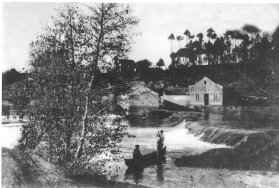
Figura 8 - Turbina, Rio Antuã.
