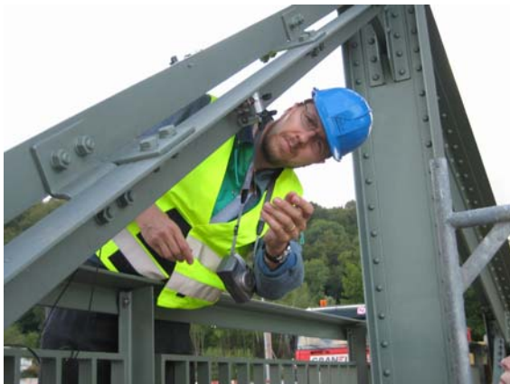
Bild 8 : Anbringen der Reibungsmessstreifen an einer Bogendiagonale
