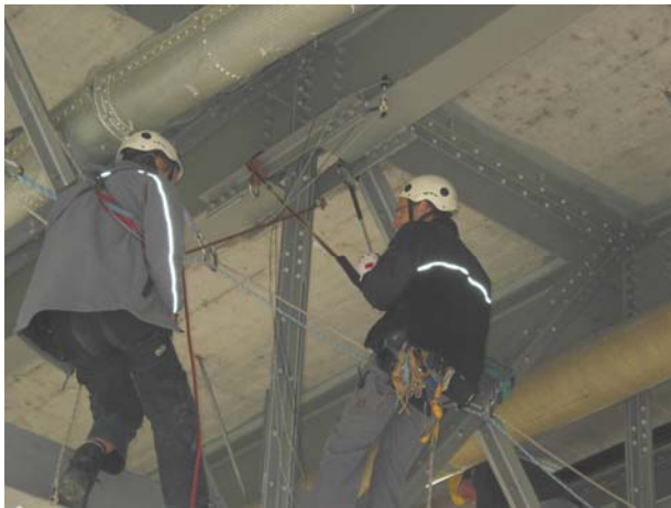
Bild 5 : Bergführer während Anbringen der Reibungsmessstreifens an Querträger
