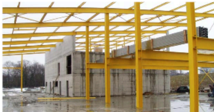
Figure 1 – Photo de la halle pendant le montage
