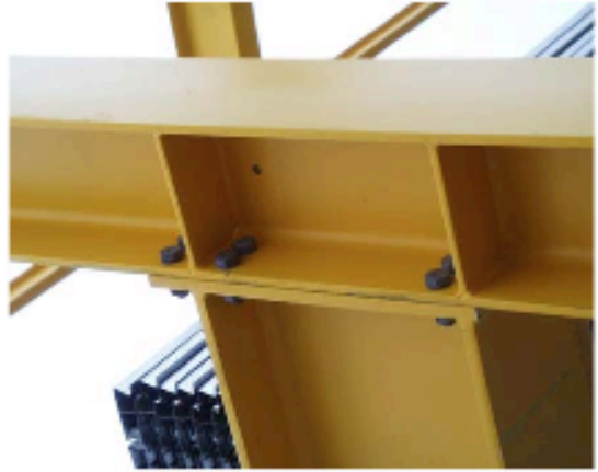
Figure 5 – Détail A : assemblage
