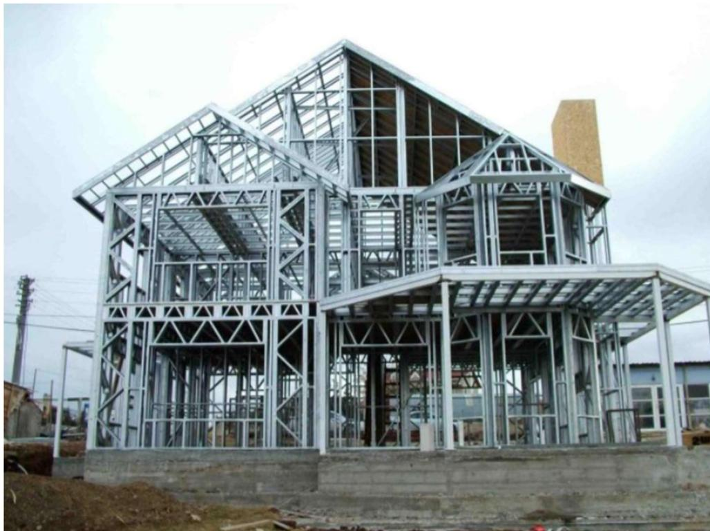
Figura 2.8 - Estrutura de uma moradia construída em LSF (ROCKS 3D, 2022).
