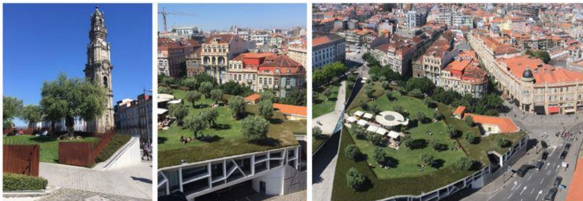
Figura 2.3 - Cobertura verde localizado na Praça de Lisboa, Porto, no contexto do edifício e da integração da cidade. Fonte: (Calheiros e Stefanakis, 2021).
