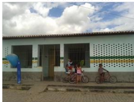
Figura 26: Fachada do prédio da escola da Várzea dos Potes
