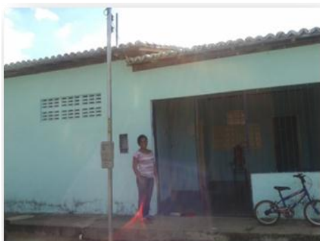
Figura 33: Fachada do prédio da escola do Cassaça
