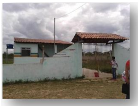
Figura 24: Fachada (b) do prédio da escola da Terra Vermelha
