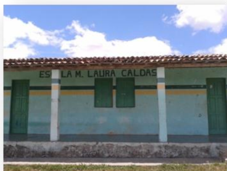
Figura 11: Fachada do prédio da escola do Limoeiro
