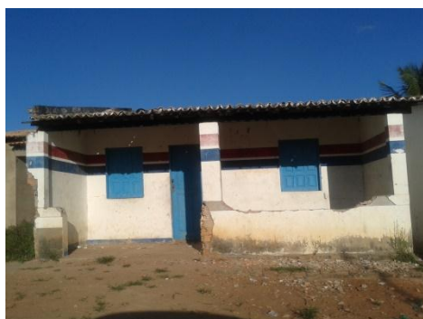
Figura 29: Fachada do prédio da escola do Retiro em reforma
