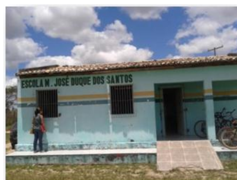
Figura 18: Fachada do prédio da escola de Alecrim
