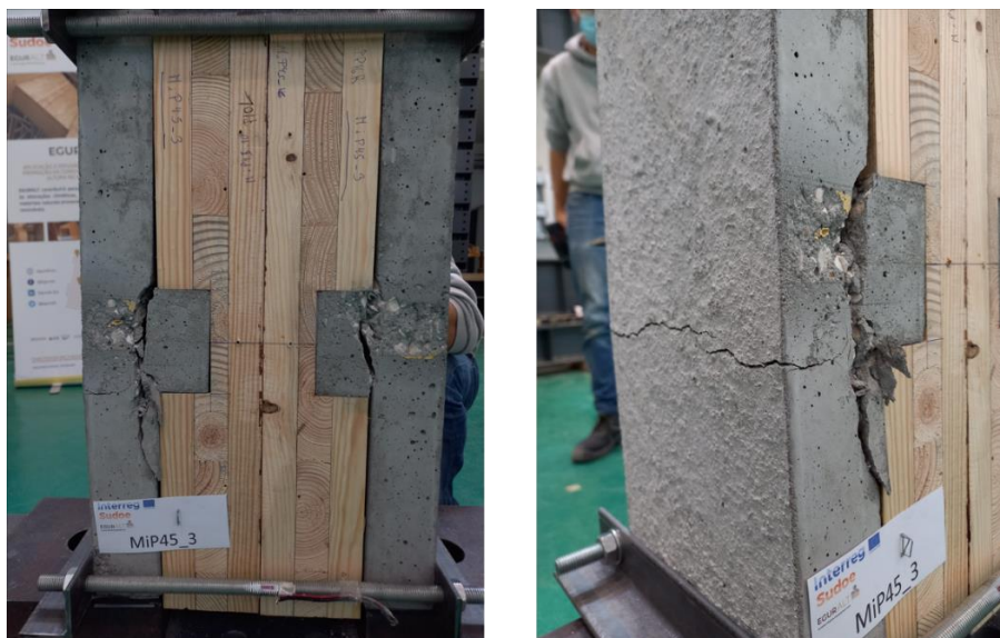
Figura 3.15 - Modos de rotura do provete MiP45_3
