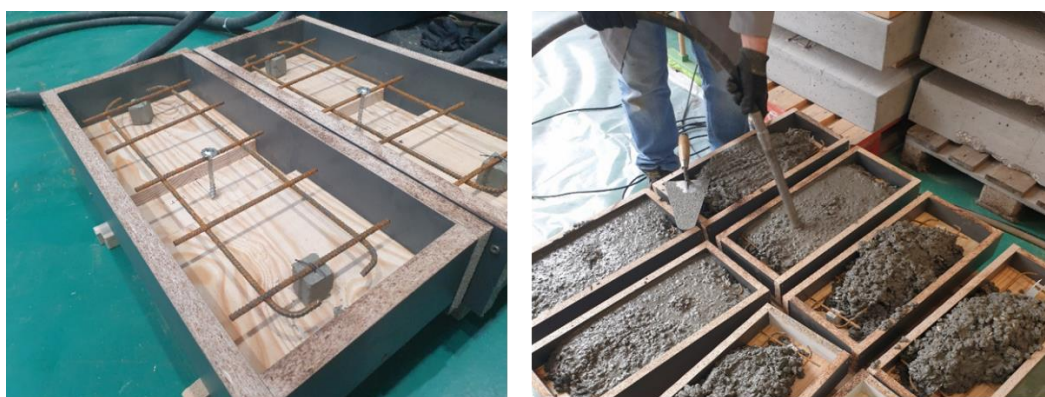
Figura 3.5 - Cofragem e betonagem
