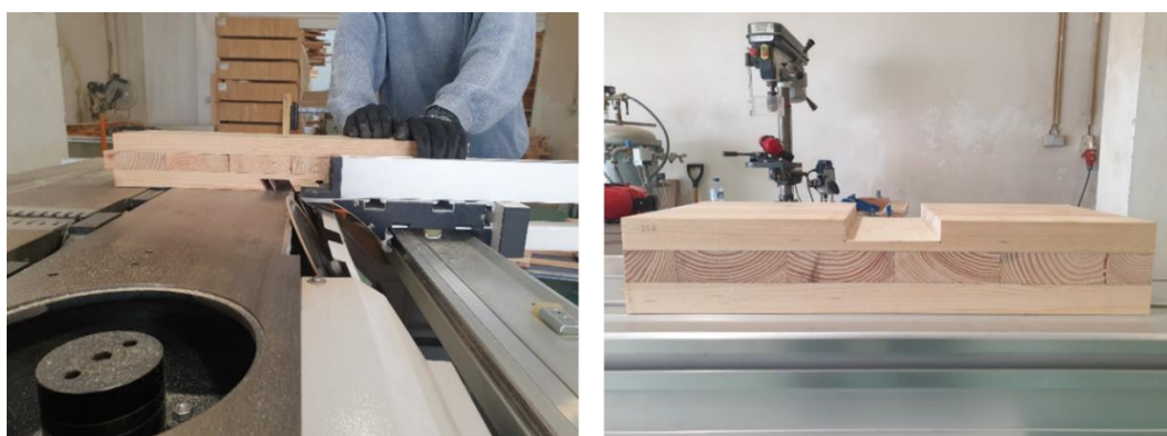
Figura 3.4 - Execução do entalhe
