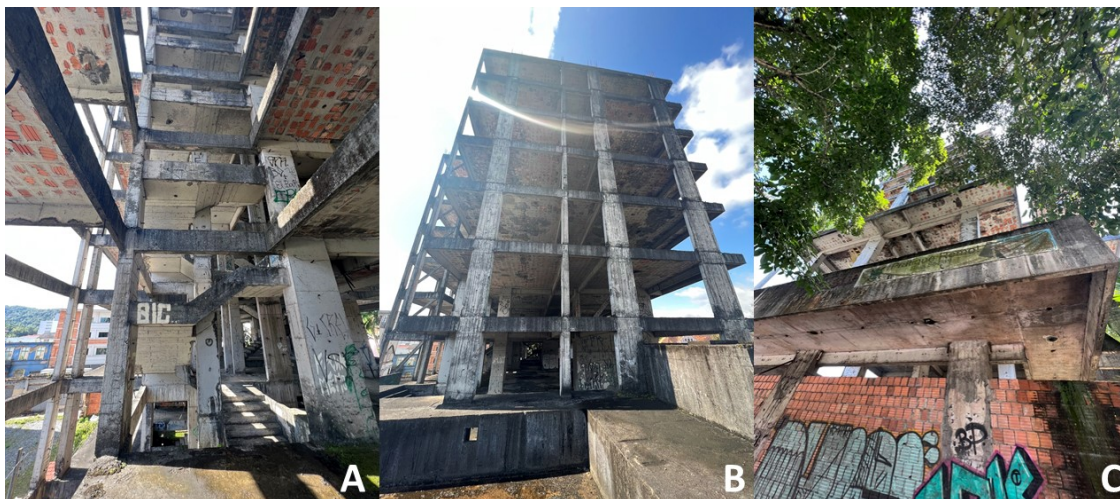
Figura 53 - Vistas exteriores do edifício: (A) parte interna do edifício entre lajes (L51-24 e L33-42); (B) fundos; (C) alçada frontal.
