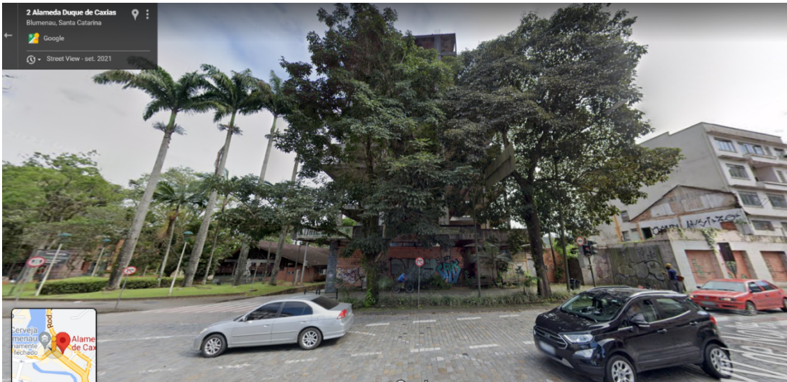
Figura 23 - Frente do edifício (Fonte: Google Maps (2021))
