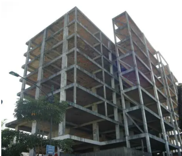
Figura 22 – Esqueleto inacabado do prédio (Fonte: Adalberto Day)
