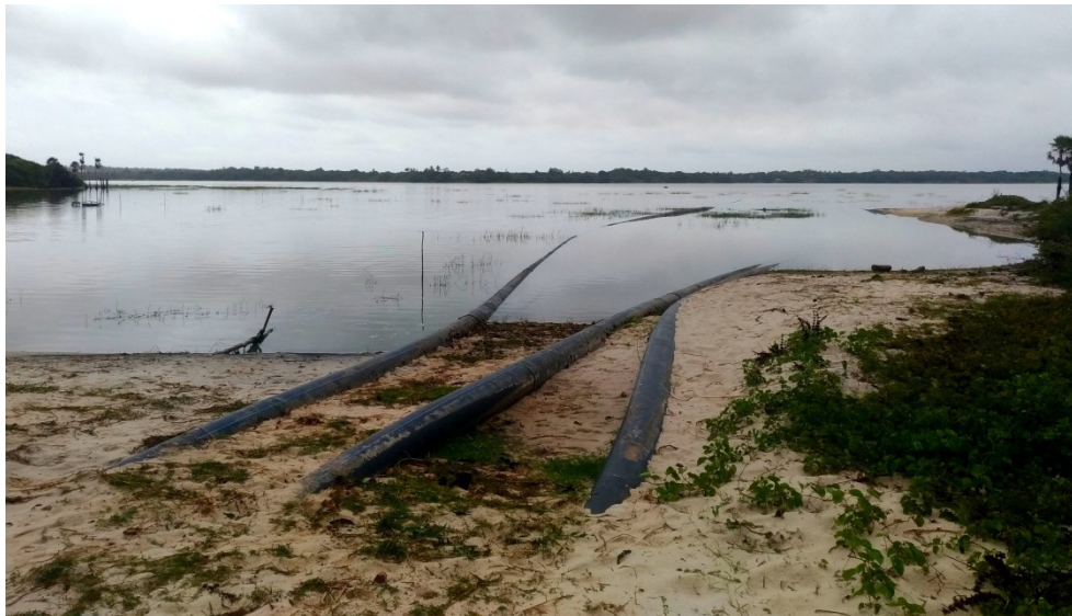
Foto 91: Dutos drenam a água das comunidades para o Complexo Industrial e Portuário do Pecém. Oficina “Água, direito humano e bem comum no Ceará”. Fortaleza, dezembro de 2018 (Trabalho de campo).
